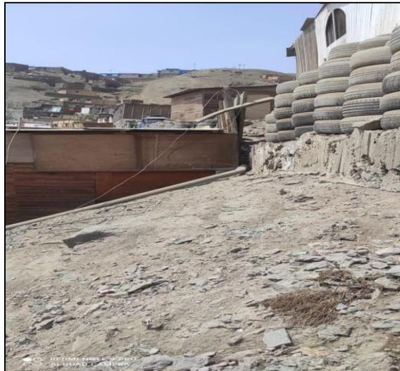
Disposición de vivienda sobre terraplenes de pircas y llantas en taludes inestables.
