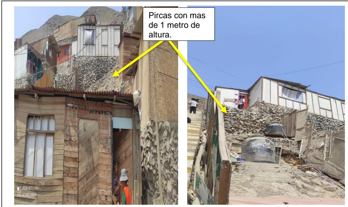
. Ausencia de muro de contención en las viviendas de material precario, también se aprecia la altura de las pircas que van más de 1 metro de altura y tanques de agua en los taludes inestables.
