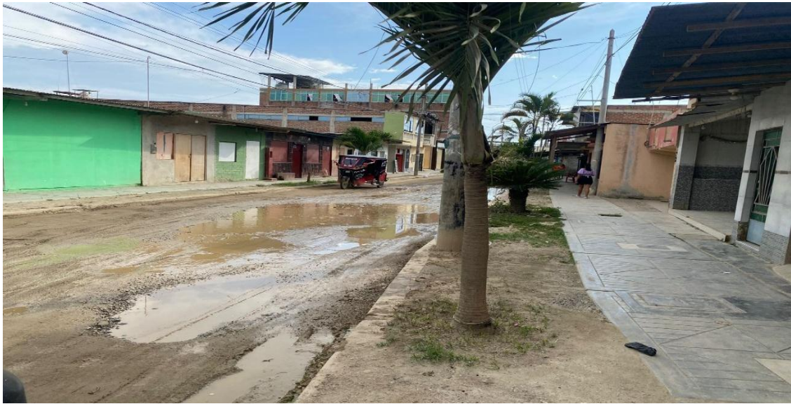
Figura N° 5. Presencia de zonas con demasiada acumulación de agua residual pluvial por falta de drenajes
