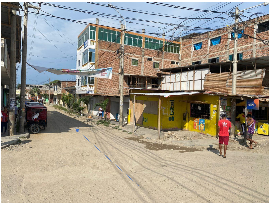
Figura N° 7. Vista panorámica de la infraestructura vial vecinal en la parte baja de la Villa Puerto Pizarro
