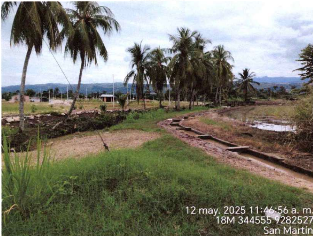
Punto inicial zona crítica de la ficha N°002 – Sector Carretera Andiviel
