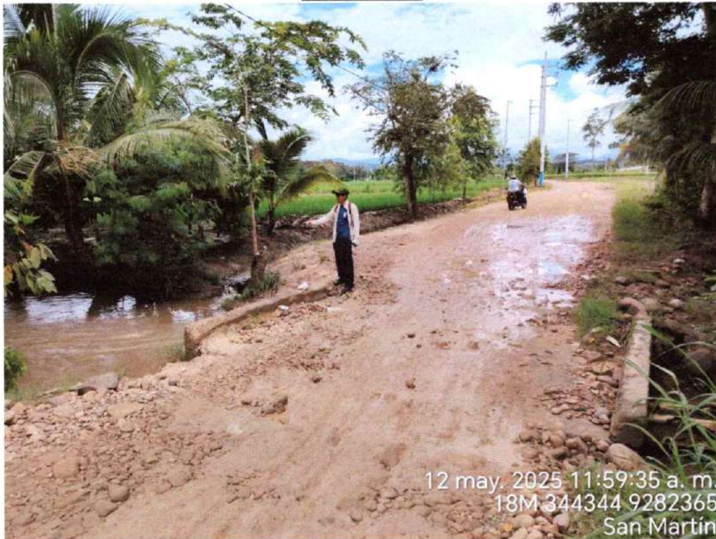
Punto final zona crítica de la ficha N°002 – Sector Carretera Andiviela
