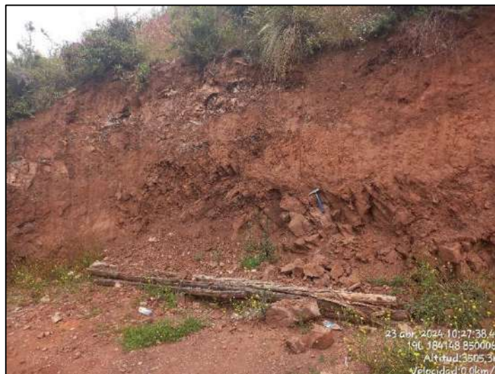
Escarpe de corte para edificación en la manzana M.
