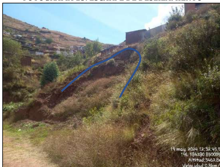
Escarpe de deslizamiento en la manzana L.
