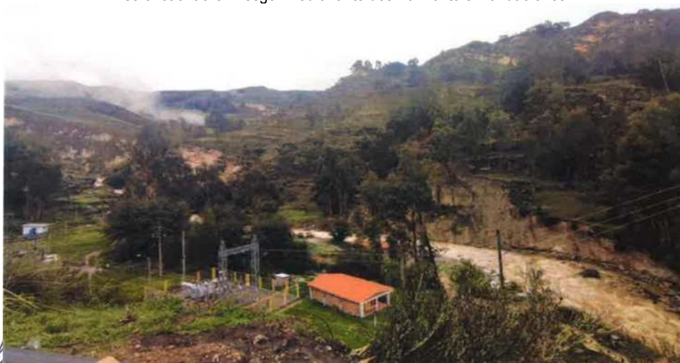
Imagen N° 13: Vista de la Central Hidroeléctrica Machu, reconocido como elemento expuesto, el cual se encuentra en riesgo "Medio" ante deslizamiento e inundaciones
