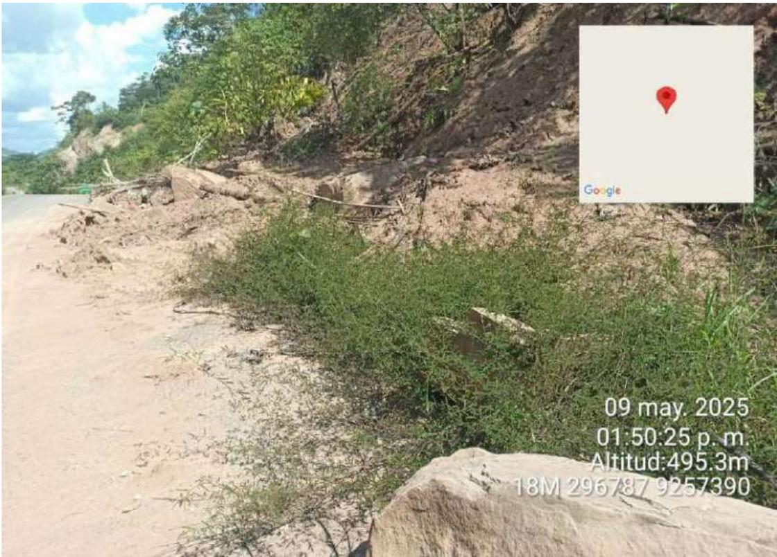
**Descripción:** Se muestra a la carretera interrumpida por los lodos, tierra y roca producto del deslizamiento a causa de las lluvias intensas.
