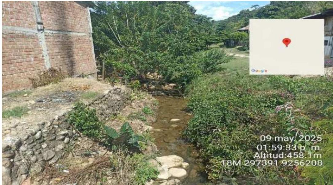
**Descripción:** En la imagen se visualiza a una vivienda ubicada a orillas de la quebrada, la cual está expuesta a la Inundación y Erosión fluvial, además se muestra la construcción artesanal de un muro o barrera de piedra y concreto.
