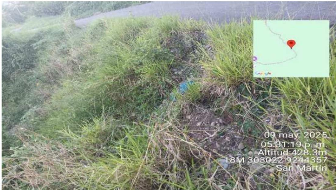
**Descripción:** Se muestra grietas y afectación a plataforma producto del deslizamiento de suelo por las precipitaciones intensas ocurridas.
