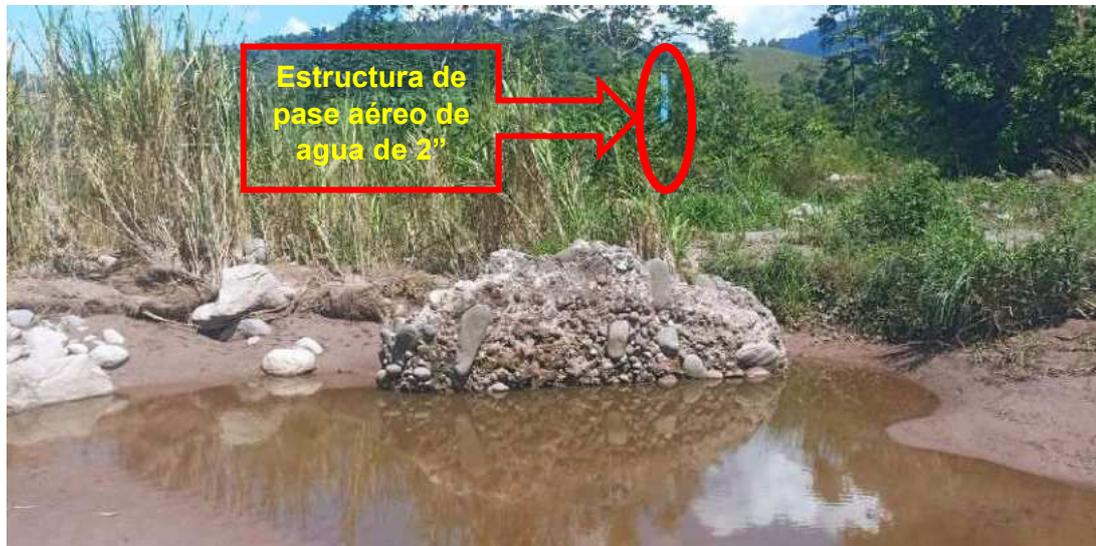
**Descripción:** En la imagen se muestra un resto de concreto y piedra construida por los pobladores para proteger la estructura de concreto del pase aéreo de agua potable, antes los crecientes incrementos del caudal de río que provoca el desborde y afecta a las viviendas y estructuras cubicados cerca de la orilla del Río, esto a consecuencia de las lluvias intensas.
