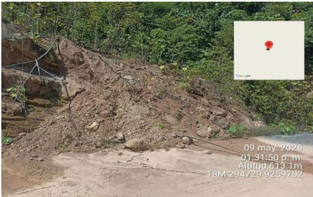
**Descripción:** En la imagen se muestra el deslizamiento de lodo, suelo y rocas hacia la carretera, esto la filtración y lluvias intensas.
