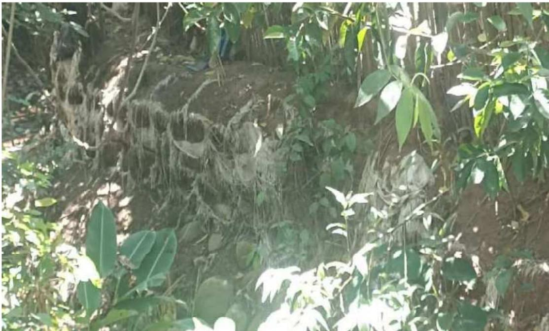
**Descripción:** Se muestra sacos con arena instaladas y deteriorados para evitar desborde de la quebrada y la erosión, ocasionado por el desborde de la quebrada a consecuencia del incremento del caudal por las precipitaciones intensas.
