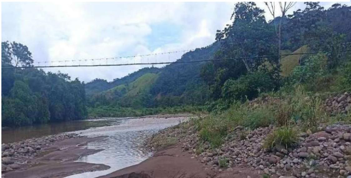
**Descripción:** En la imagen se puede visualizar el pase aéreo de 2 pulgadas, que abastece de agua potable a la población del CC.PP. Nueva Vida; la cual se ve expuesta la estructura de concreto de la margen derecha con dirección al norte, ante los desbordes eventuales del Río Saposo.
