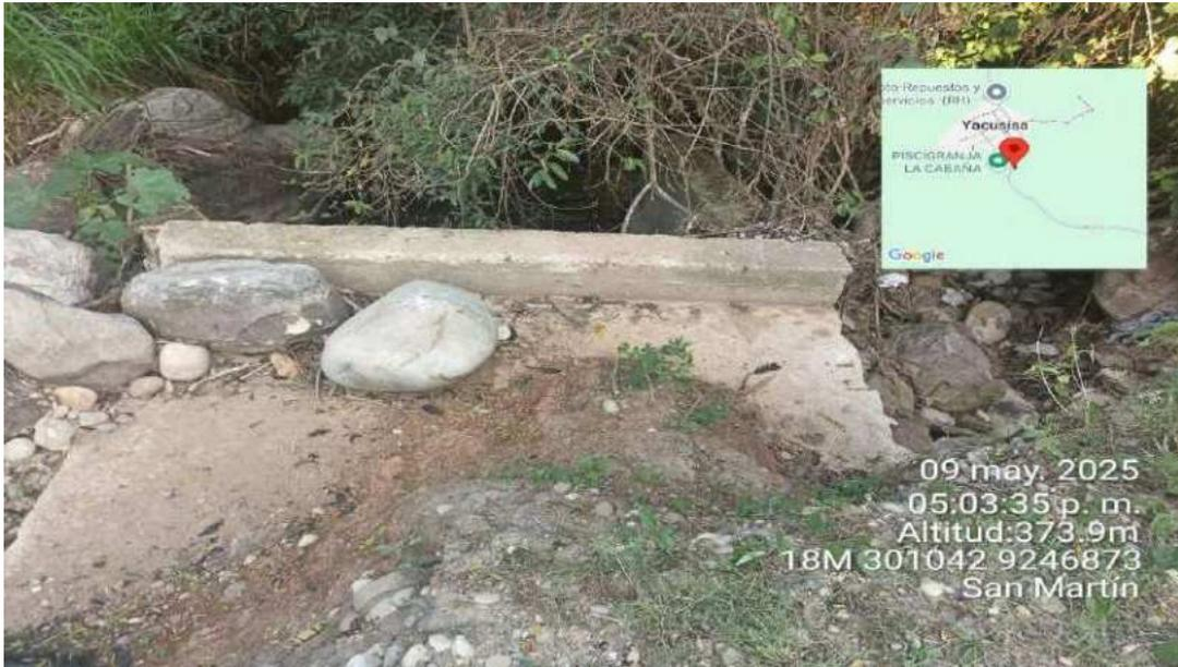
**Descripción:** En la imagen se muestra la erosión e inundación que ha sufrido la alcantarilla y la plataforma de la carretera, producto del desborde de la quebrada por el incremento significativo del caudal el cual sobrepasa el caudal actual de la alcantarilla existente.
