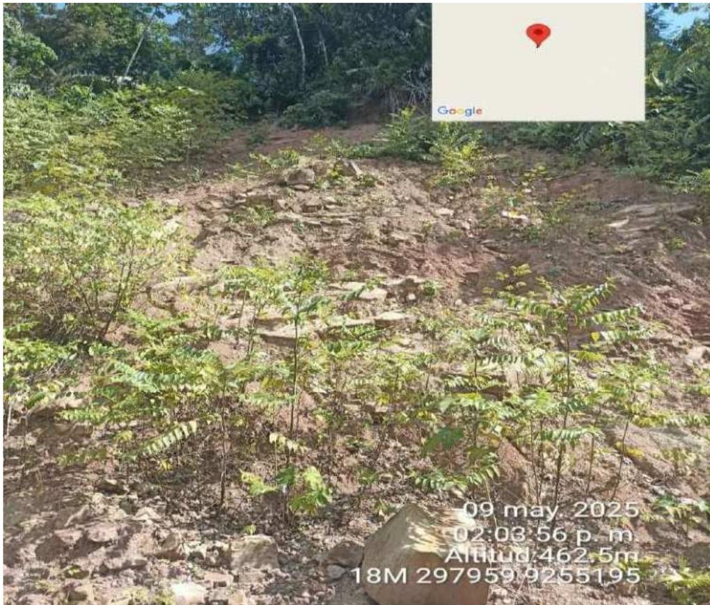
**Descripción:** Se muestra en la imagen el deslizamiento de rocas, suelo y arbustos ocasionados por las precipitaciones; lo cual ha ocasionado el tapado de una parte de la vía hacia Nueva Vida
