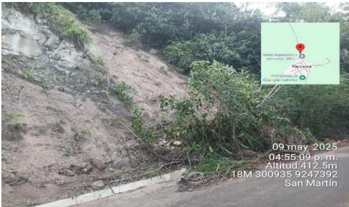
**Descripción:** En la imagen se muestra el deslizamiento de suelo arenoso ocasionado por las lluvias intensas y afecta a carretera.
