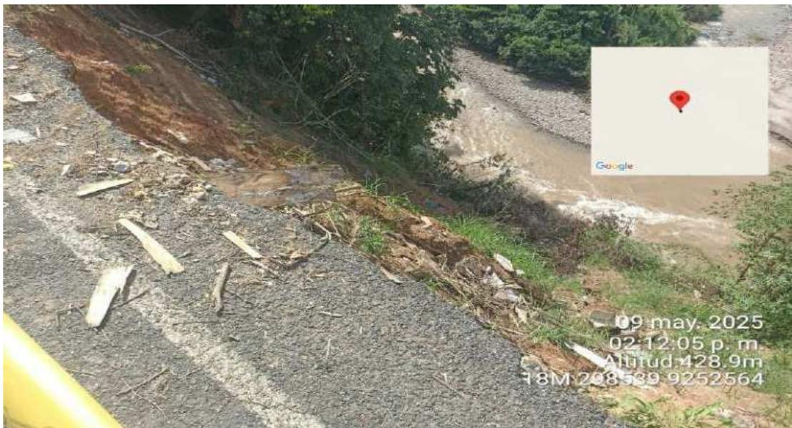
**Descripción:** En las imágenes se muestra que el río ha erosionado y socavado el borde o riera del río y esto a ocasionado el deslizamiento o derrumbe de parte de la plataforma de la carretera.
