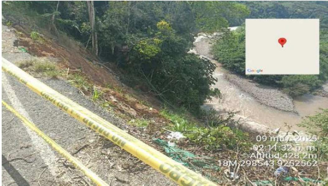
*Imágen N° 41: Carretera en riesgo de colapsar por deslizamiento a causa de socavación de río*
