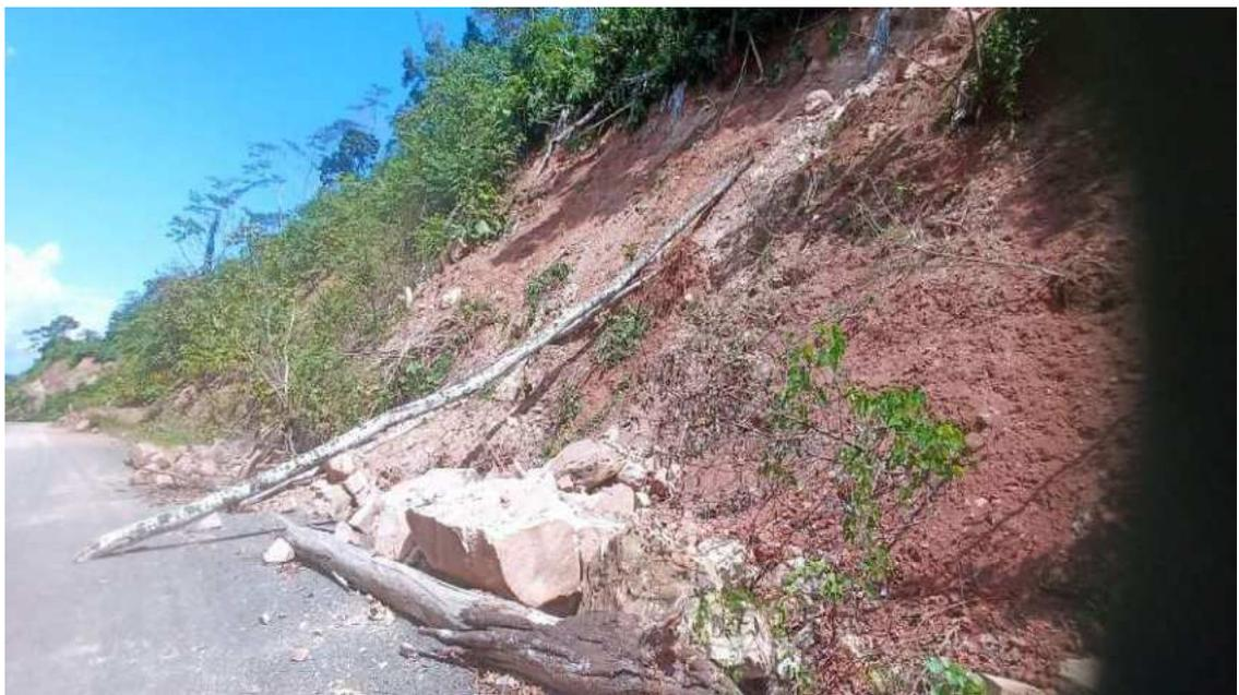
**Descripción:** Se muestra tramos de deslizamiento de roca, suelo y arbustos en la margen izquierda de la carretera.
