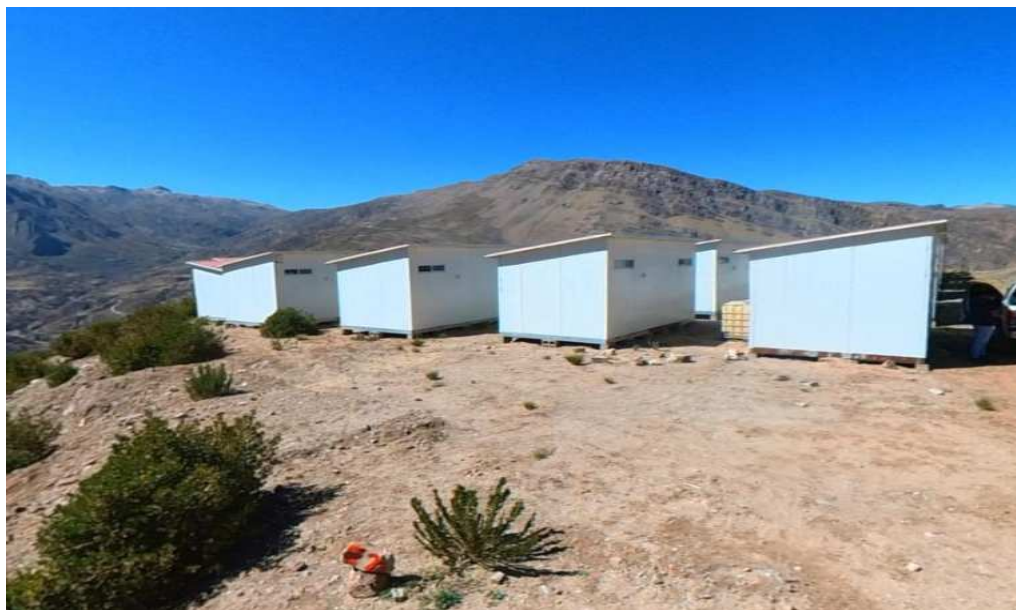
FOTO N° 8 Módulos prefabricados situados a un costado del terreno evaluado en el sector de Piñotapata.
