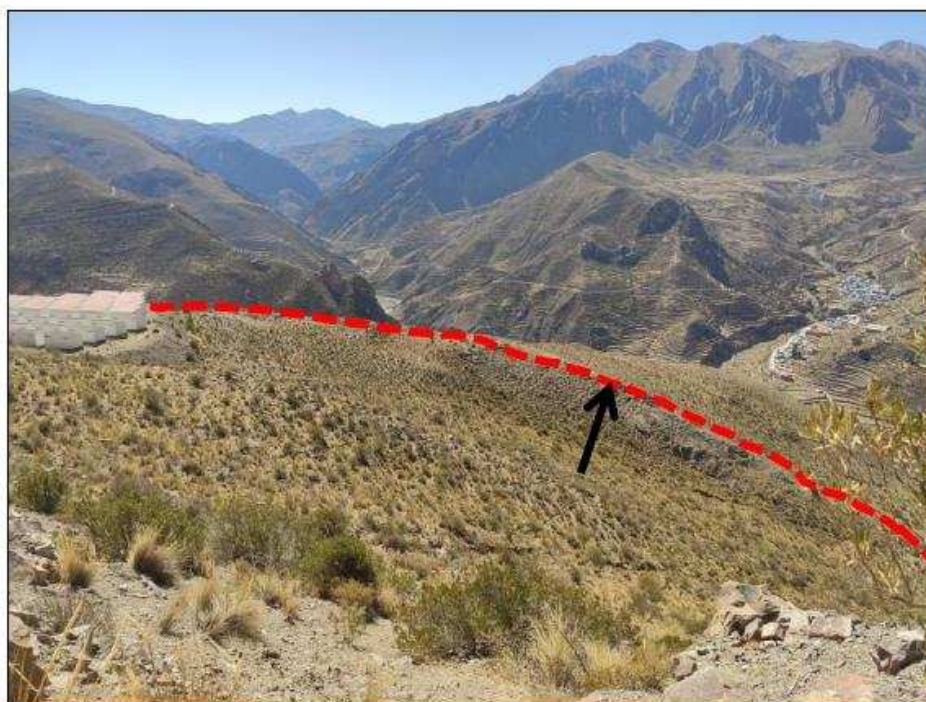
IMAGEN N° 14 Se aprecia escarpe con presencia de fracturas
