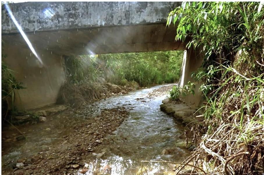
Foto 11. Puente debilitado por la erosión de la base de sus estribos.
