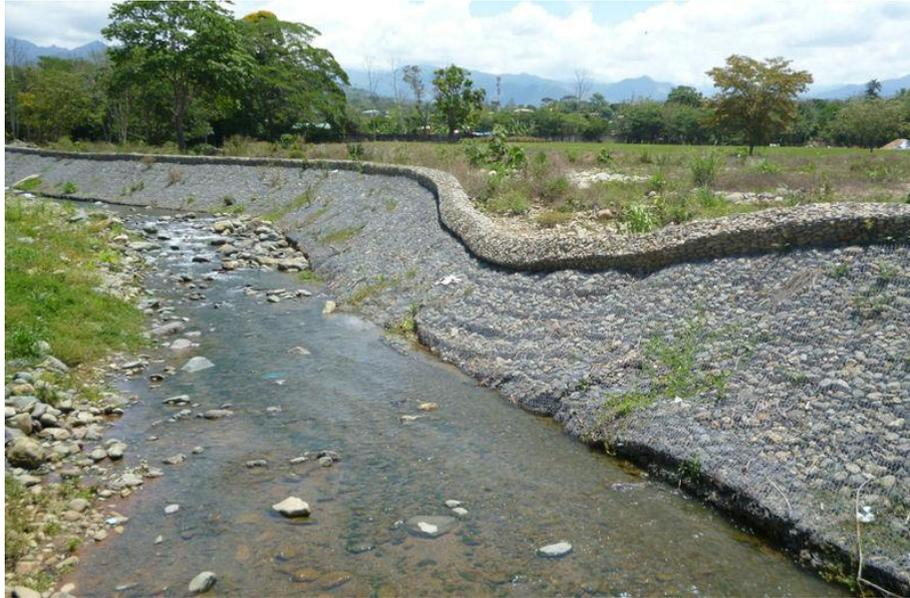
Foto 19. Vista de gaviones recubrimiento colocados como defensa fluvial.
