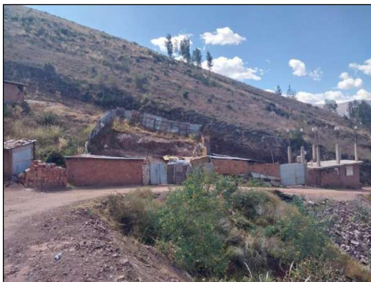
FOTOGRAFÍA 5. ARENISCAS MODERADAMENTE FRACTURADAS
