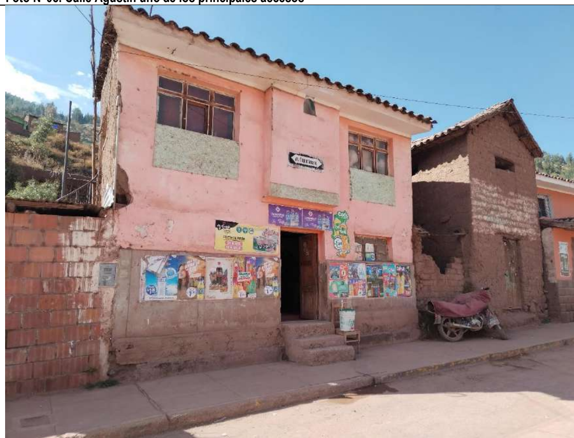
Foto N°06, precariedad en las viviendas y negocios dentro del ámbito inmediato.
