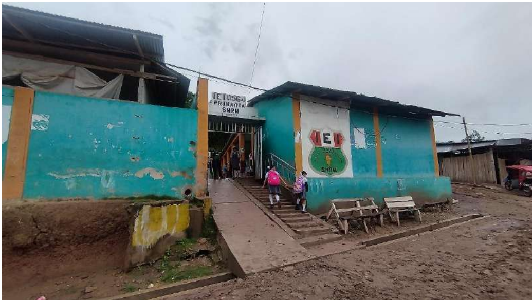
Ilustración N°07: Infraestructura de la Institucion Educativa N° 00564 – Inicial y Primaria
