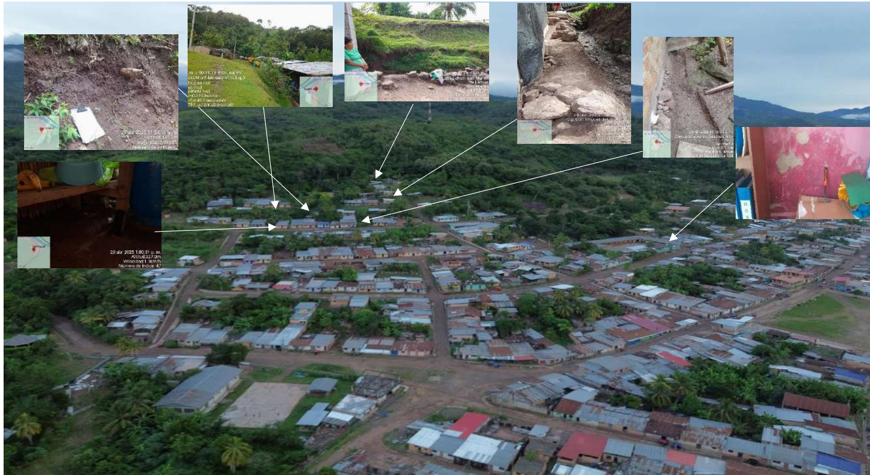
Lustración N°26: Área de viviendas con presencia de ojos de agua y presentan humedad alta en épocas de lluvias.
