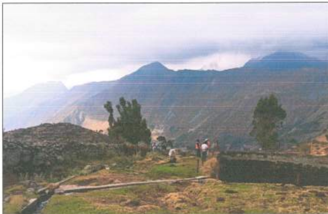
Foto 8: Identificación del área de estudio, evidenciando el pozo de agua y canales con revestimiento y sin revestimiento.
