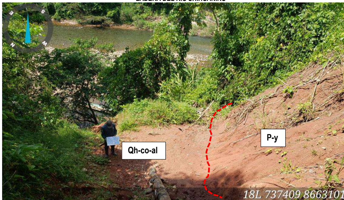
FOTOGRAFIA N°19. VISTA DEL DEPÓSITO COLUVIO – ALUVIALES RECIENTES, ZONA DE DESLIZAMIENTO EN LA LADERA DEL RIO SHIHUANIRO
