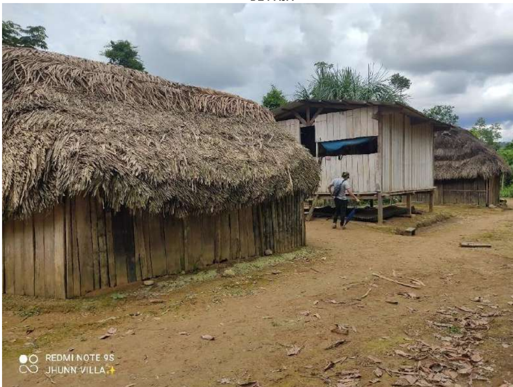
FOTOGRAFIA N°6. CARACTERISTICAS DE LAS VIVIENDAS DE LA CC.PP. TIMPIA, VIVIENDA DE MADERA CON TECHO DE PAJA
