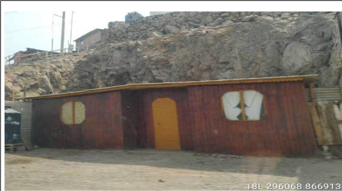
Vivienda expuesta a un deslizamiento, construida con paredes de madera y techo de calamina en la ASC. DE VIV. VILLA CAMPIÑA
