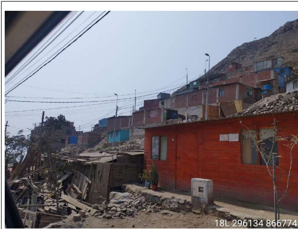
Vivienda de un nivel con techo de calamina en la ASOC. DE PROP. NUEVA PRIMAVERA.
