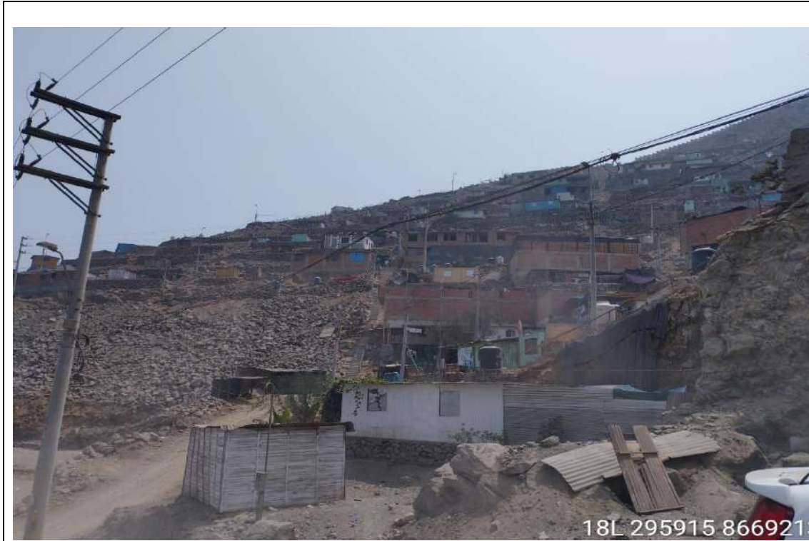
Vivienda de un nivel con paredes de madera y ladrillo que cuentan con una escalera incompleta en la COOP.DE VIVIENDA VILLA LOS PERIODISTAS
