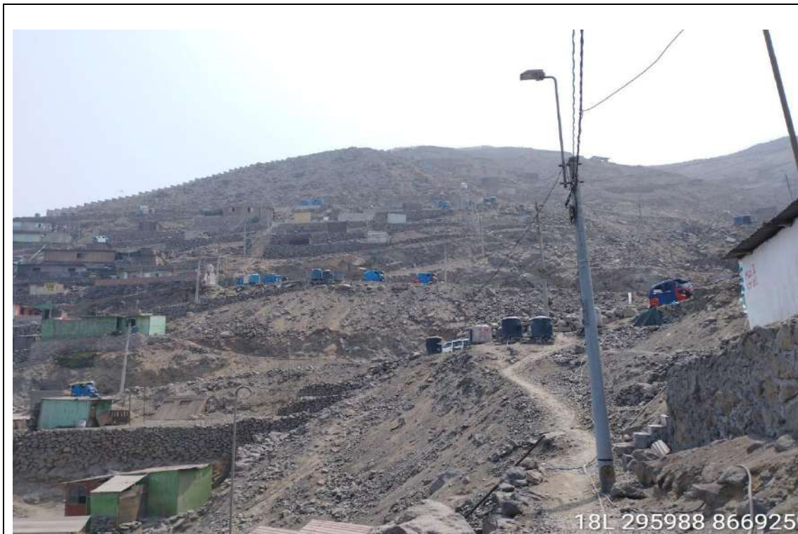
Falta de escalera en la COOP.DE VIVIENDA VILLA LOS PERIODISTAS
