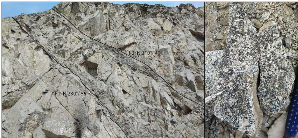
Figura 18. Izquierda; Vista de afloramiento con presencia de fallas y diaclasas.
