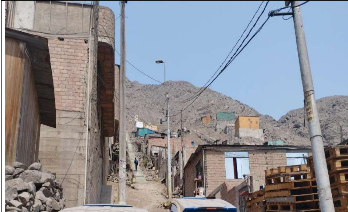
Se observan viviendas con paredes de ladrillo y escalera incompleta sin barandas en la ASOC. DE PROP. NUEVA PRIMAVERA
