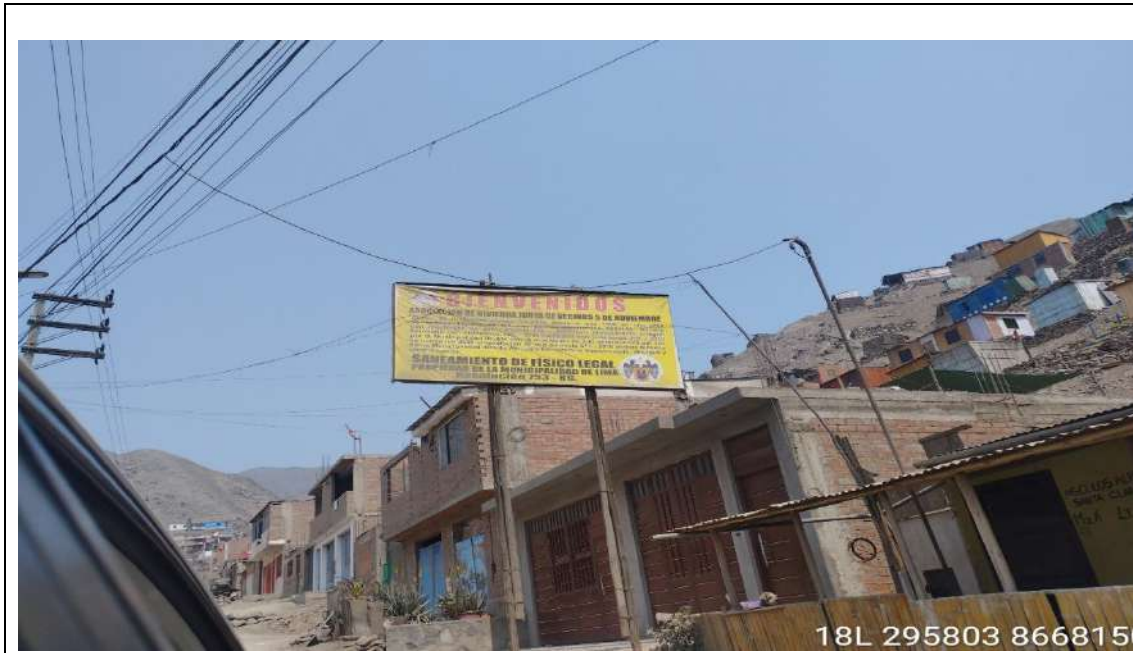
Viviendas construidas con paredes de madera y techo de calamina en la parte alta y viviendas con paredes de ladrillo en la parte baja de la ASOC. DE PROP.DE VIV. LOS ALPES SANTA CLARA
