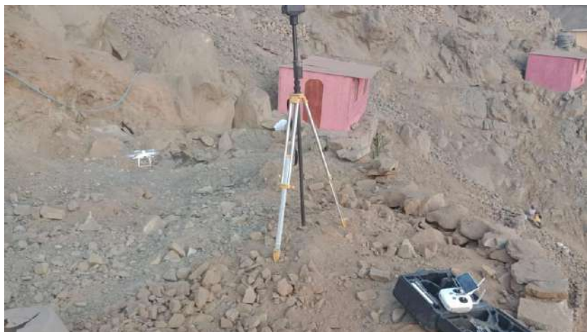
Figura 4. Levantamiento topográfico en el ámbito 6
