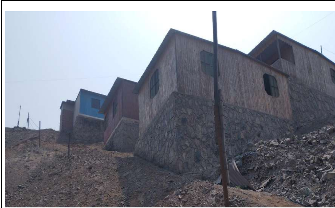
Presencia de muros de contención en la URB LAS TERRAZAS DEL PUEBLO
