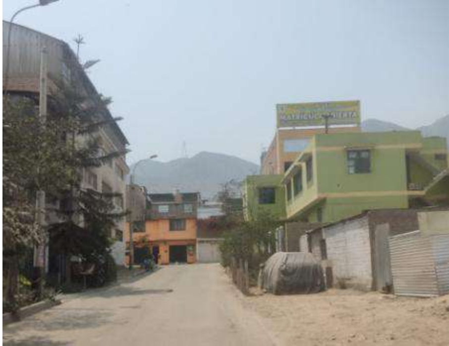
Predominancia de viviendas construidas con ladrillos en la ASC. DE VIV. HIJOS DE APURIMAC I ETAPA
