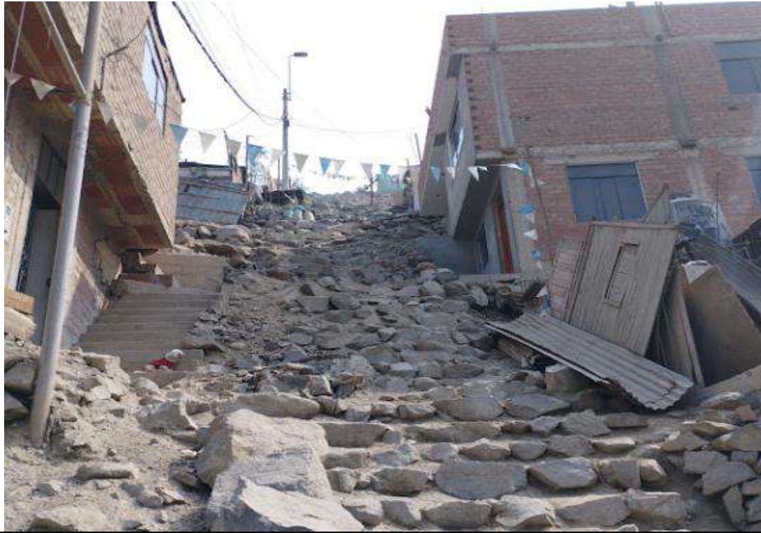
Acceso en muy mal estado a las viviendas en el AA. HH LA PUNTILLA
