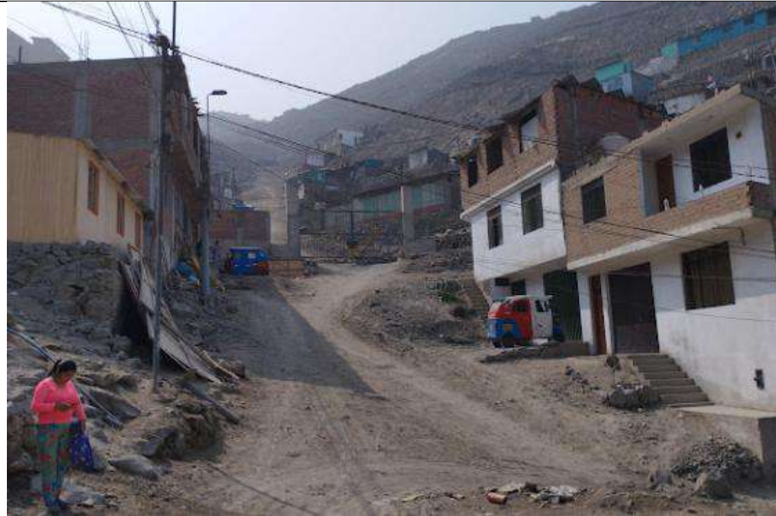
Viviendas construidas con paredes de ladrillo y predominancia en viviendas de paredes de madera en mal estado en AA. HH. LA PUNTILLA
