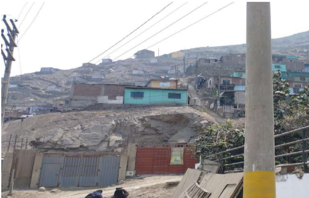
Predominancia en viviendas con pared de madera y techo de calamina en la ASC. DE VIV. EL PARAISO DE SANTA CLARA-ATE
