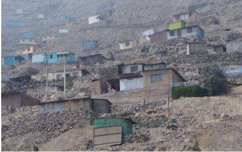
Viviendas en mal estado con paredes de madera y techo de calamina en ASC. DE VIV. NUEVA GENERACION DE SANTA CLARA
