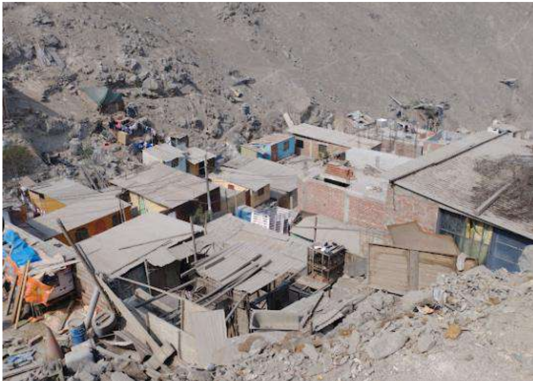
Viviendas con techos en mal estado en el AA. HH LA PUNTILLA
