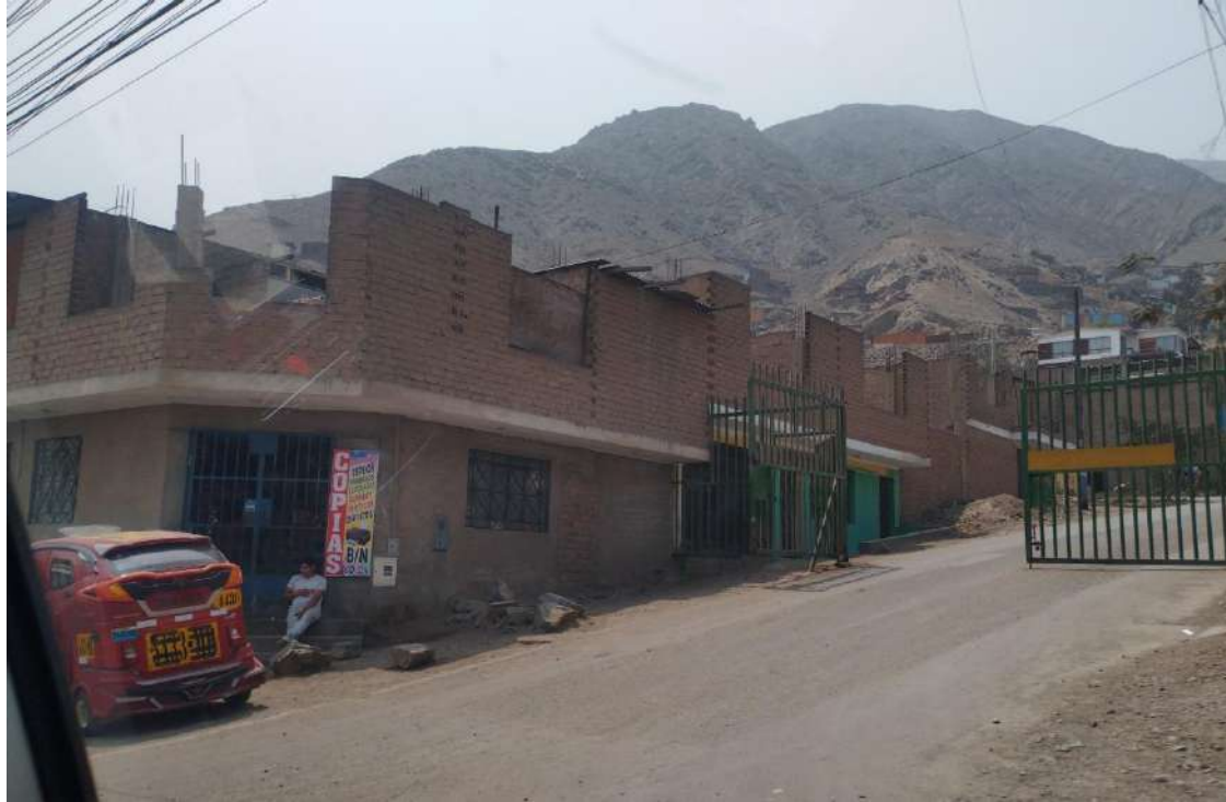
Se observan viviendas de 2 niveles en el cual el primer nivel es utilizado como comercio en la ASC. DE VIV. HIJOS DE APURIMAC II ETAPA
