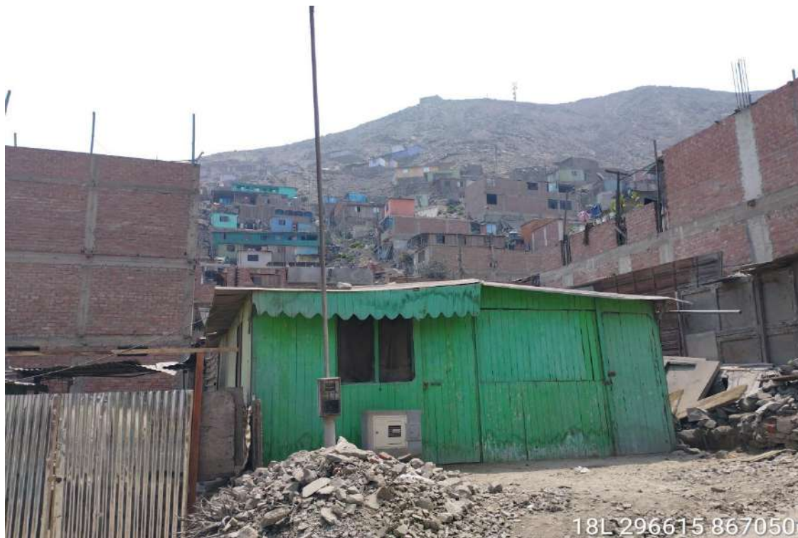
Se observa vivienda con paredes de madera en mal estado así como también la predominancia de viviendas con paredes de ladrillo en la ASC. DE VIV. EL PARAISO DE SANTA CLARA-ATE
