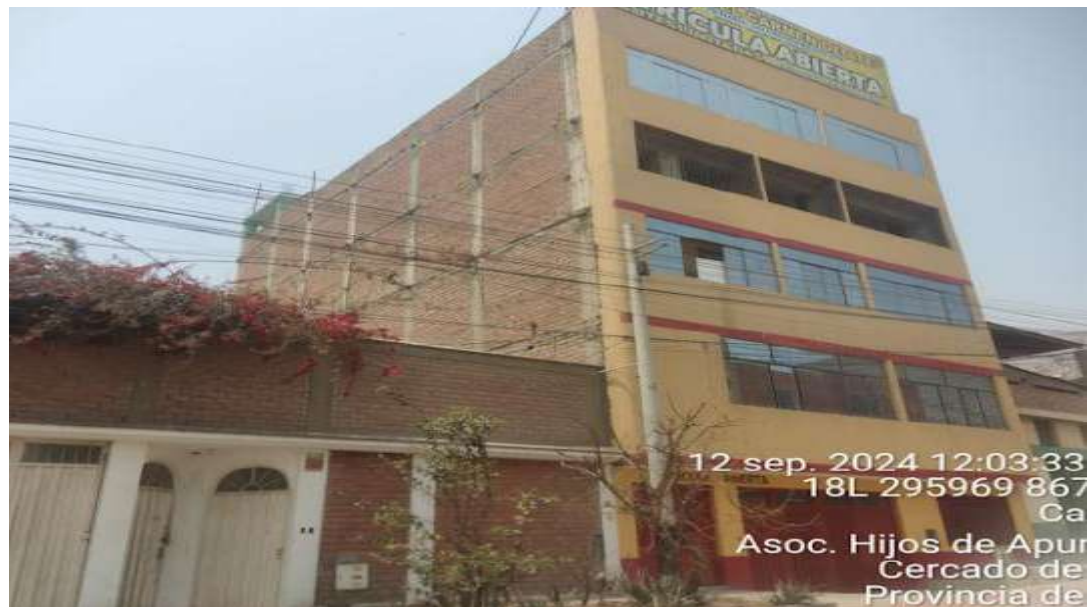
Vista de viviendas de 5 niveles en la ASC. DE VIV. HIJOS DE APURIMAC I ETAPA
