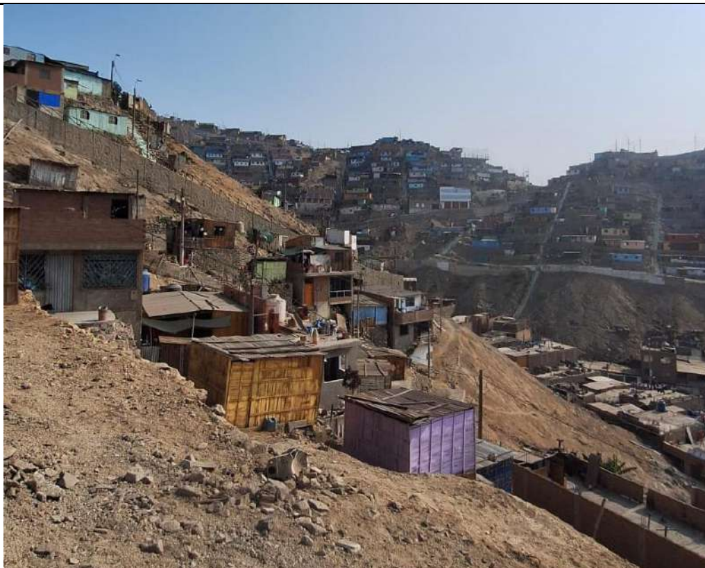
Se observan viviendas de ladrillos y madera de más de un piso en la AH Las Lomas de Amauta Sector 1
