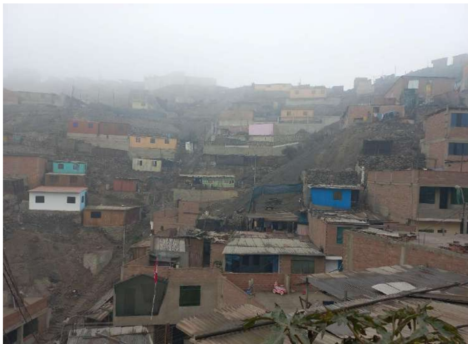
Se observan viviendas de un nivel con paredes de ladrillo y de madera en el AAHH INMACULADA CONCEPCION - SECT A-2.
