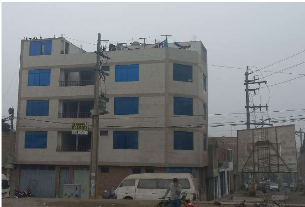
Se aprecia edificación de 5 niveles en el AAHH AREA DE PAMPITA ANEXA AL DE LA LOTIZACION DELFUNDO LA ESTRELLA
