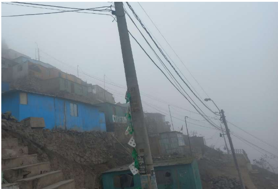
Se observa el acceso al alumbrado público en viviendas del AAHH AH NUEVO AMANECER - PARCELA 1.
