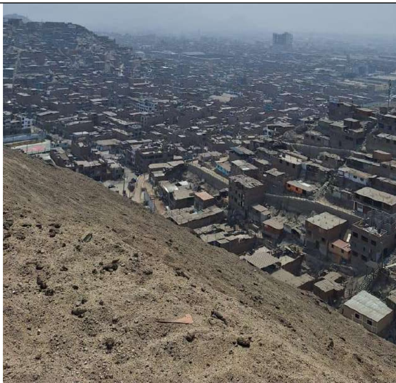
Se observan viviendas de ladrillos de más de un piso en la AH EL AMAUTA ZONA A
