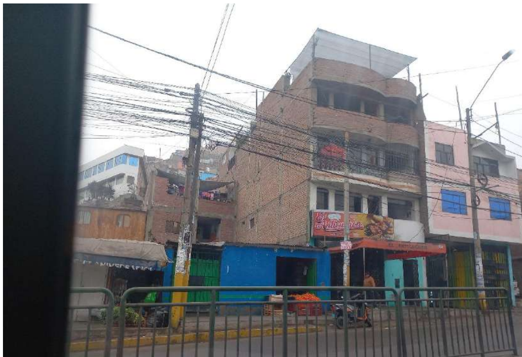
Se aprecia la coexistencia de construcciones de 1 nivel con edificaciones de 5 niveles en el AAHH AREA PAMPITA ANEXA DE LA LOTIZACION DELFUNDO LA ESTRELLA
