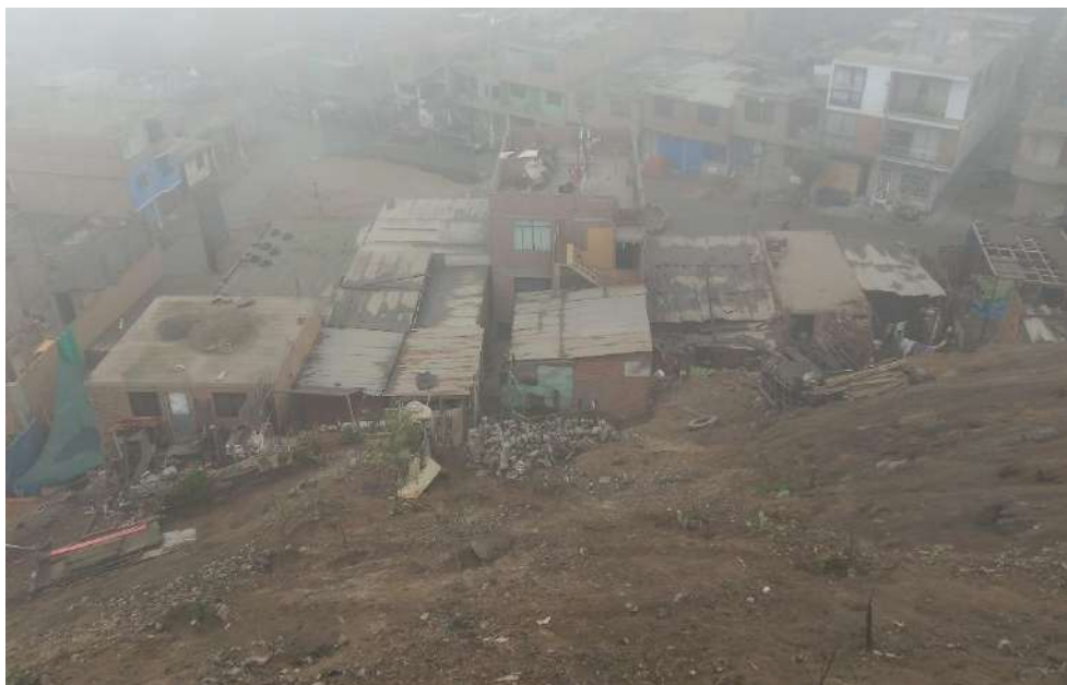
Agrupación de viviendas construidas con ladrillo y madera en el AAHH VIRGEN DE FATIMA.
