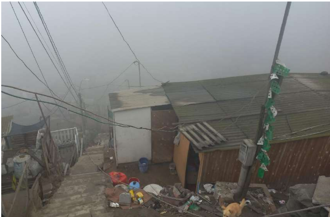
Se observan viviendas con paredes de madera y techo de calamina en el AAHH ASENTAMIENTO HUMANO: MONTERREY B.
