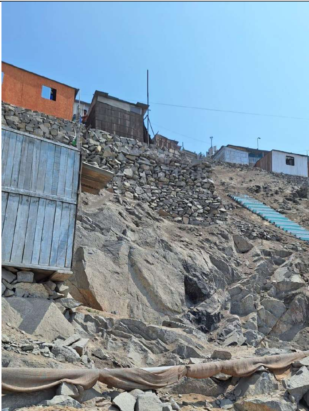
Se observan viviendas de madera con cimientos de pirca de un piso en la Asociación Los Triunfadores 2
