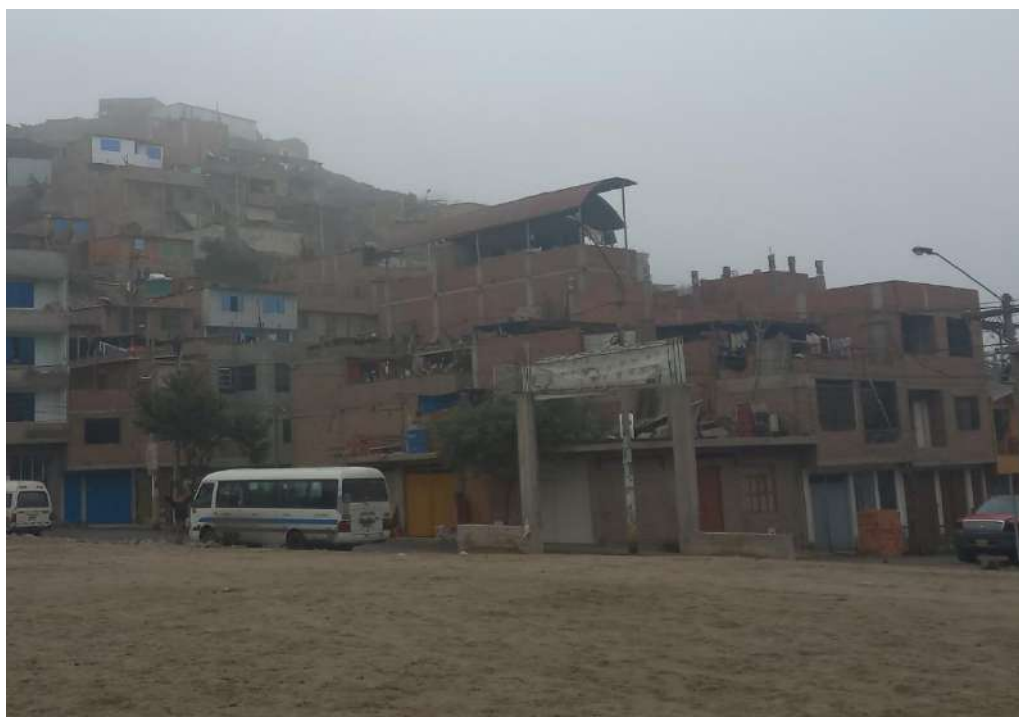
Se observa predominio de edificaciones de 2 niveles a más en el AAHH INMACULADA CONCEPCION SECT A-1.
