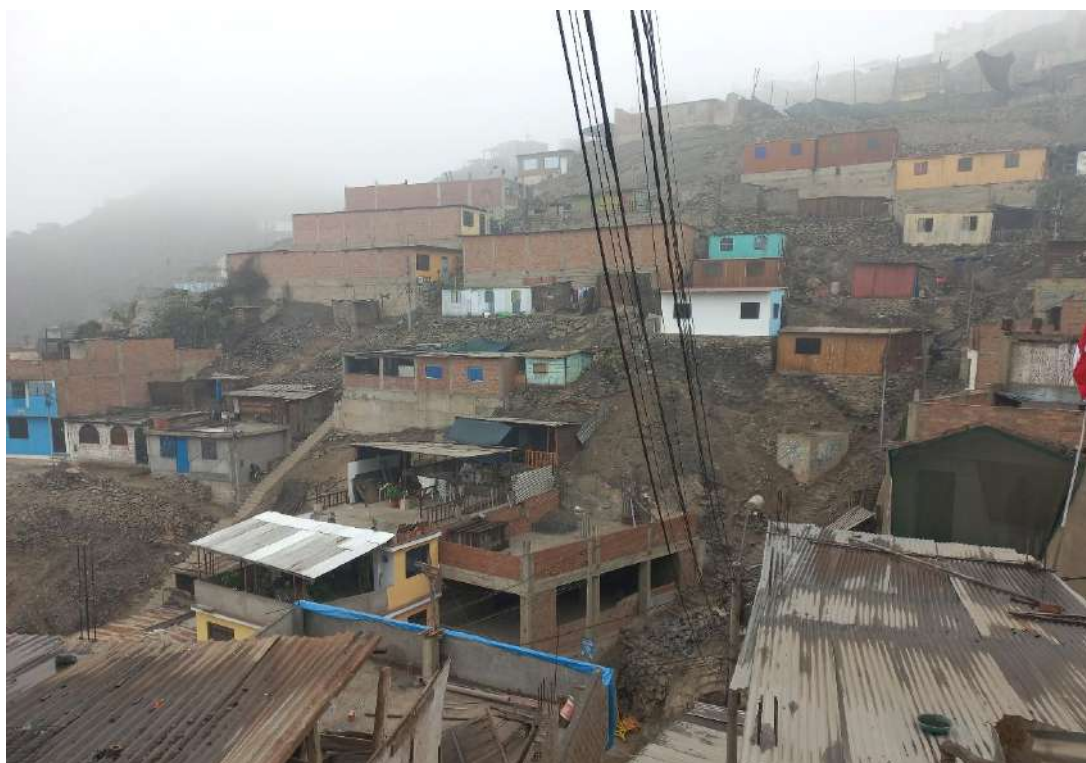
Se observan viviendas de un nivel con paredes de ladrillo y de madera en el AAHH EL AMAUTA ZONA A
