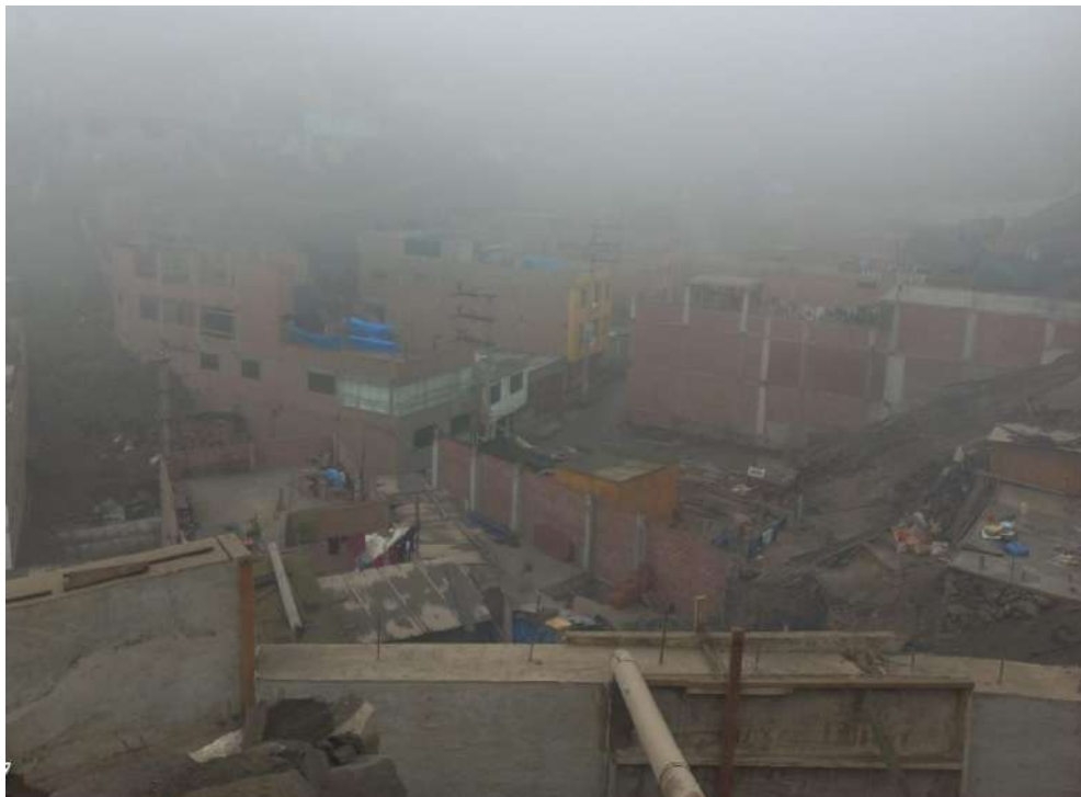
Vista de viviendas construidas con ladrillo y de varios niveles de edificación en el AAHH EL VALLE DE MONTERREY III.
