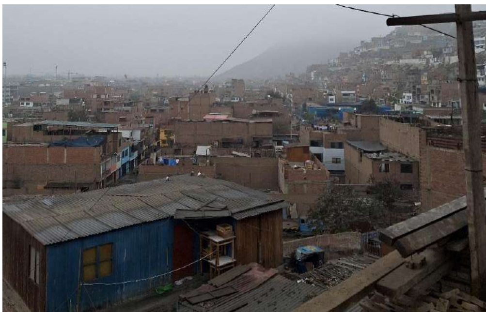
Se observa una vivienda con paredes construidas con madera y techo de calamina en el AAHH San Antonio.
