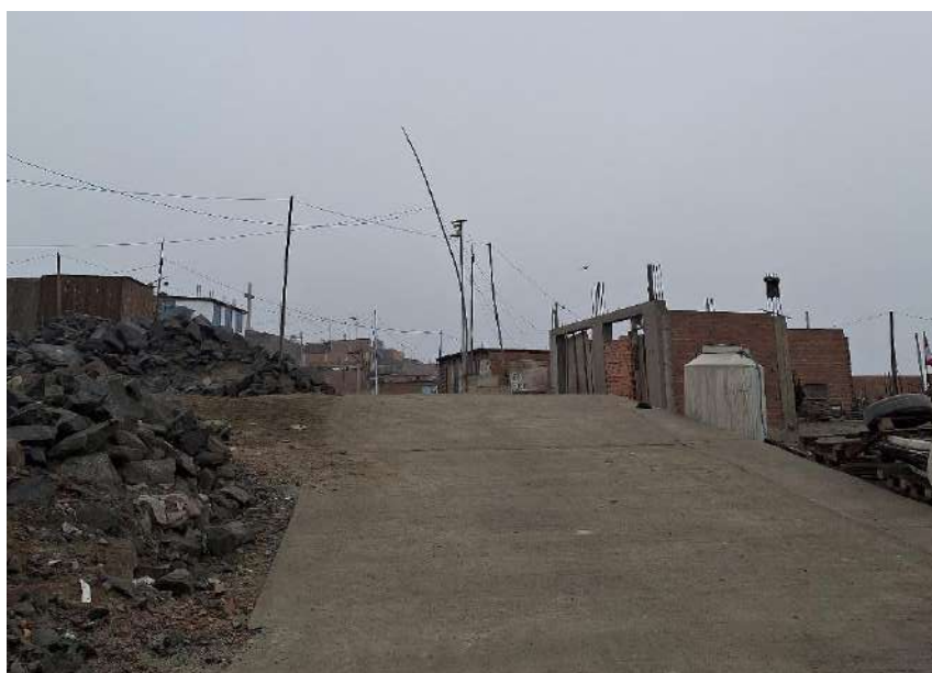
Se observan viviendas de material noble en estado de construcción en el AAHH San Pedro de Ate.
