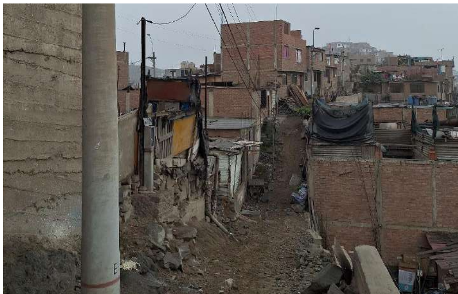
Se observa vivienda construida con madera y en mal estado de conservación en el San Pedro de Ate.
