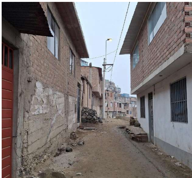
Se evidencia la predominancia del ladrillo y losa aligerada como material de construcción en viviendas del AAHH San Pedro de Ate.
