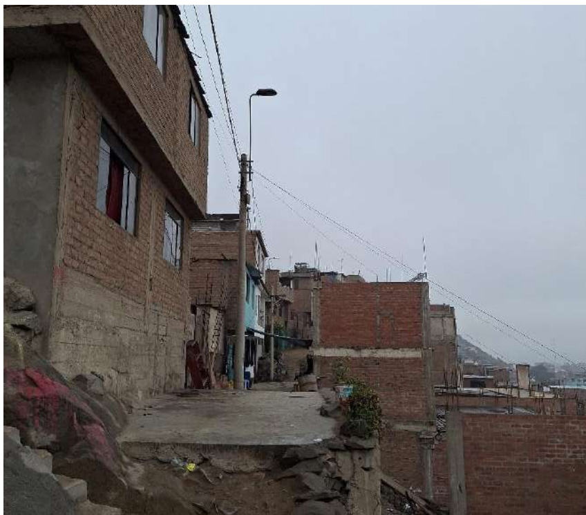
Se observan el predominio de viviendas de material noble y con más de un nivel en el AAHH San Pedro de Ate.
