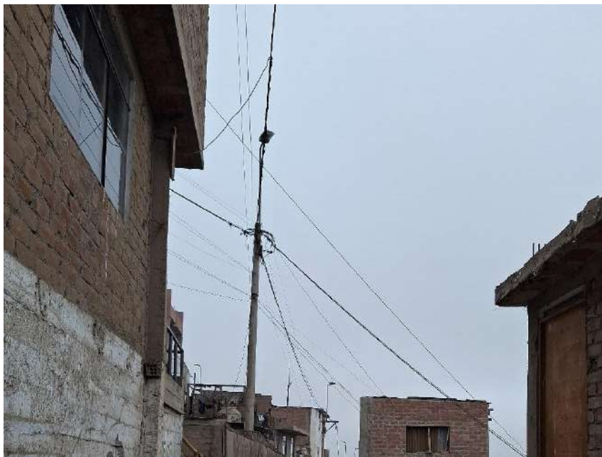
Se observa iluminación mediante red pública en el AAHH San Pedro de Ate.
