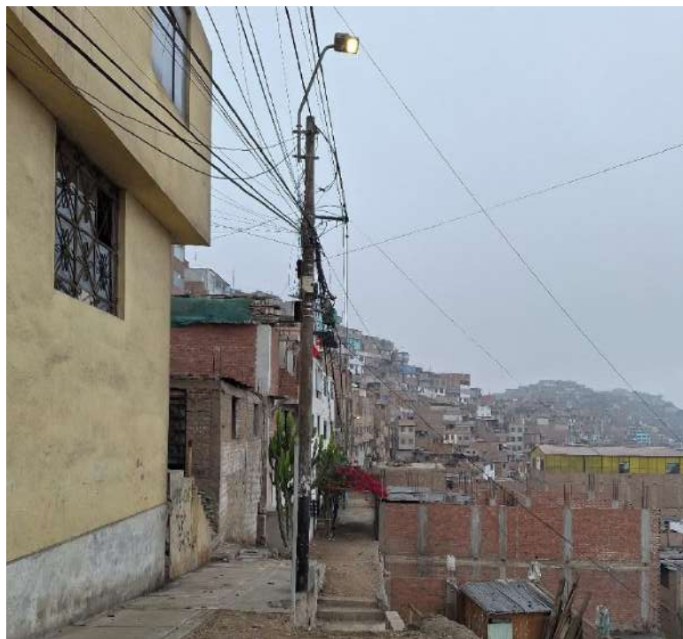
Se observa iluminación mediante red pública en el AAHH San Pedro de Ate.
