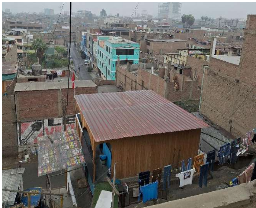
Se observa una vivienda de construcción reciente paredes de madera en Asociación de Vivienda 1 de Enero.
