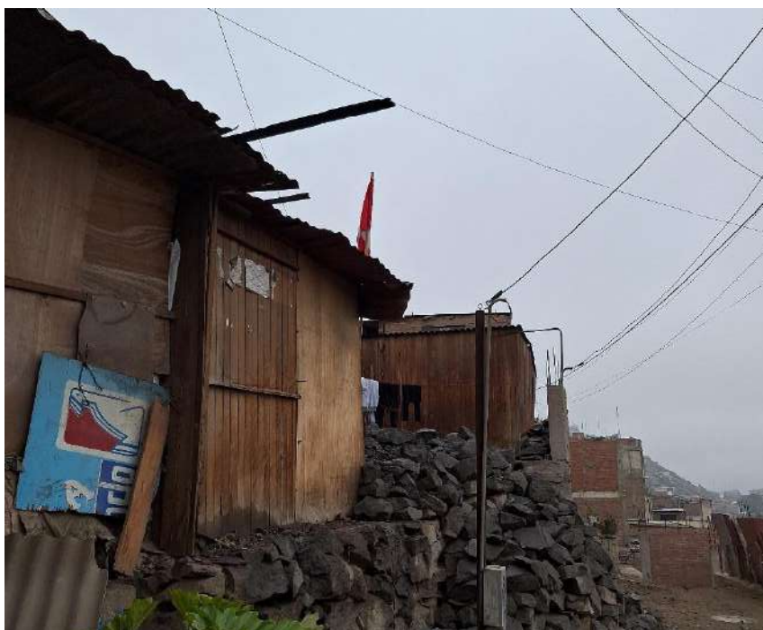
Se observan viviendas con paredes construidas con madera y techo de calamina en el AAHH San Pedro de Ate.
