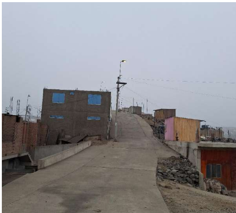
Se observan viviendas con segundo nivel construidos tanto con ladrillo como con madera en el AAHH San Pedro de Ate.
