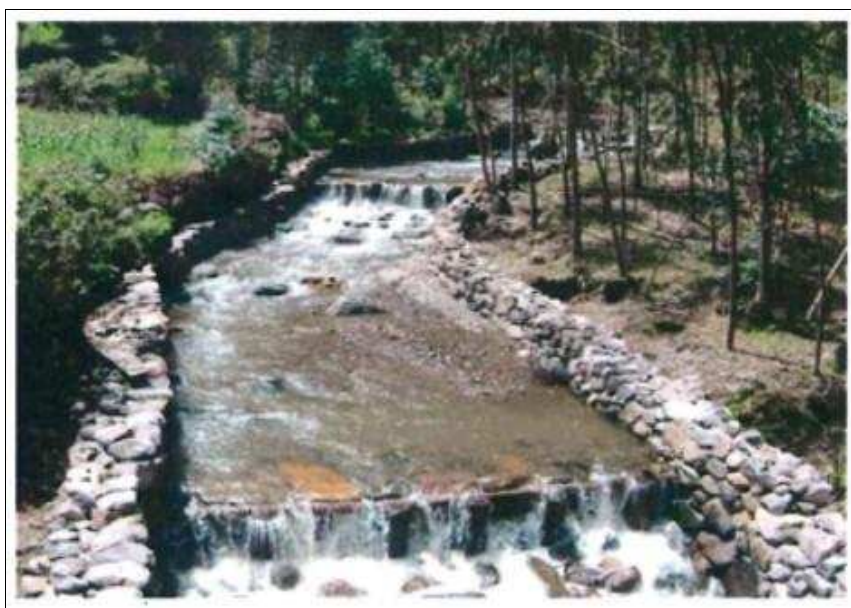
ILUSTRACIÓN 7: VISTA DE DISIPADOR DE ENERGIA
