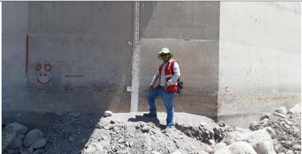
Visita de campo al Puente Huaracanito con escala Hidrométrica que proveen información sobre el crecimiento del nivel de agua en el río Huaracane.
