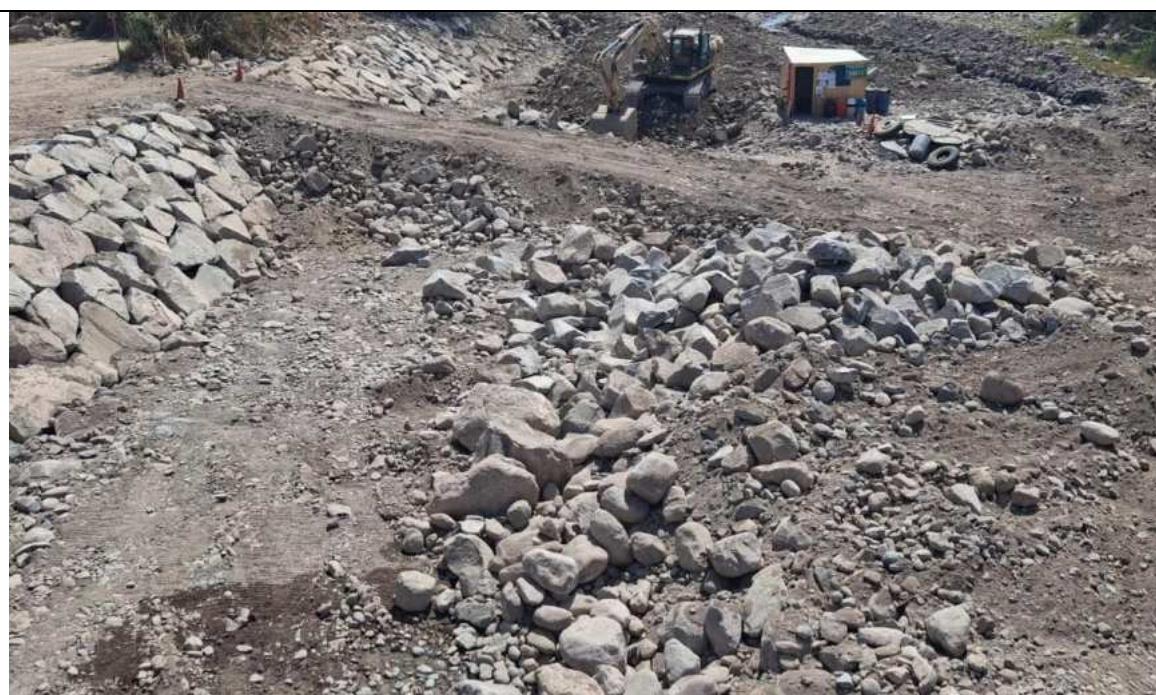
Vista de los trabajos de descolmatación con maquinaria en el cauce del río Huaracane
