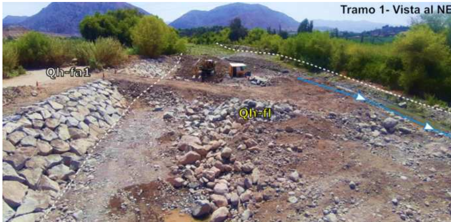
FOTO 7:: Vista de campo de la unidad geológica Depósito Fluvial (Qh-fl).
