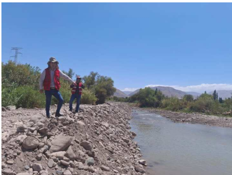
ILUSTRACIÓN 4: VISTA DE LOS DIQUES EXISTENTE EN EL CAUCE DEL RÍO HUARACANE
