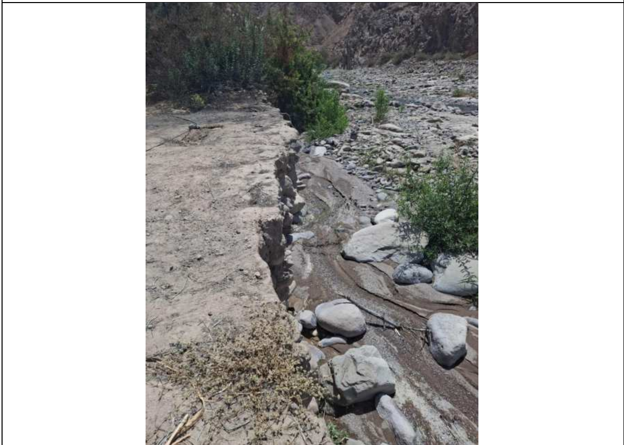
Visita de campo en la zona más alta del ámbito de estudio con erosión causada por el incremento del caudal del río Huaracane
