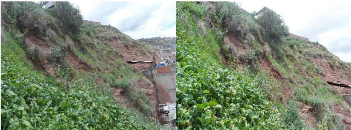
Foto 5: Vista de la erosión del talud en el sector de la calle retamales manzana Ñ lotes 8 y 7 a efectos del tipo de material que se presenta en dicha zona (Arena arcillosa - SC) presentando un PELIGRO ALTO y una VULNERABILIDAD de MUY ALTO a ALTO
