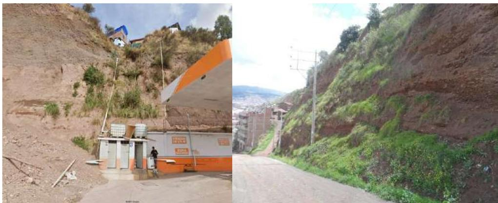
Foto 2: Vista de la Erosion a efectos de la inundación pluvial ubicado en la calle Costa Verde ubicado en la parte central y margen izquierda de la zona de estudio cuyo material está compuesta de arena arcillosa
