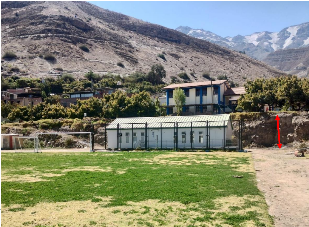
Fotografía N°02 – Desniveles de hasta 6 m entre estructuras
