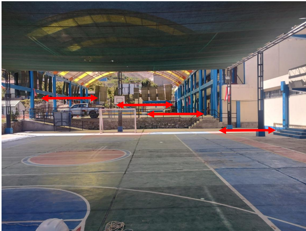
Fotografía N°05 – Los diferentes niveles de las estructuras existentes
