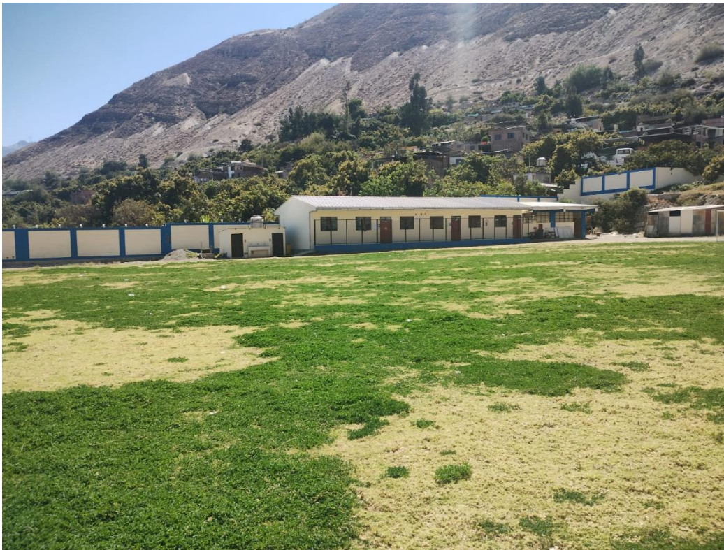
Fotografía N°01 – Aulas prefabricadas y/o módulos
