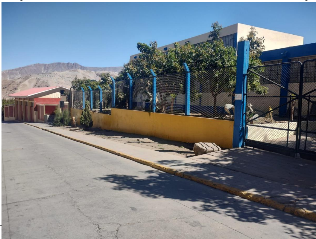
Fotografía N°06 – Fachada de la Institución Educativa Mariscal Domingo Nieto
