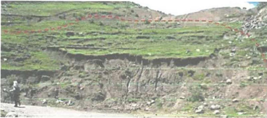
*Fotografía 1. Deslizamientos superficiales en las progresivas Km 6+710-6+740 y Km 6+170-6+190; formados en depósito coluvial poco profundo que cubre a rocas de la formación Ausangate, fenómenos pequeños que se formaron por la presencia de manantes en ambos casos y además falta de cuneta en el primer tramo (presencia de trocha por encima de la vía en estudio).*
