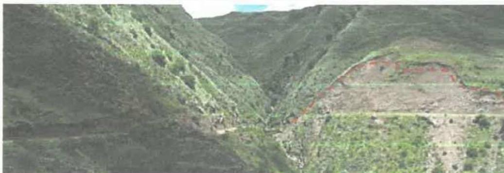
*Fotografía 3. Se observa el derrumbe en la progresiva Km 3+426-3+486 del camino vecinal Urateac – Tamborpuquio, fenómeno que se desarrolló en depósito coluvial, en ladera de pendiente fuerte.*
