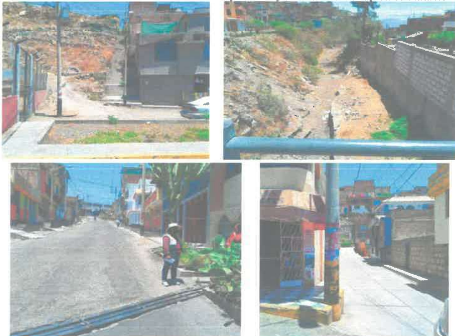
Imagen 53: Vulnerabilidad de lotes colindantes a la quebrada y alcantarilla de rápida colmatación
