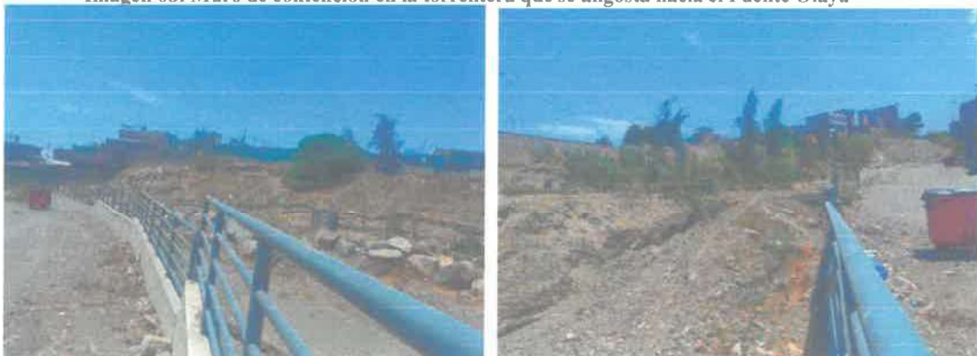
Imagen 68: Muro de contención en la torrentera que se angosta hacia el Puente Olaya
