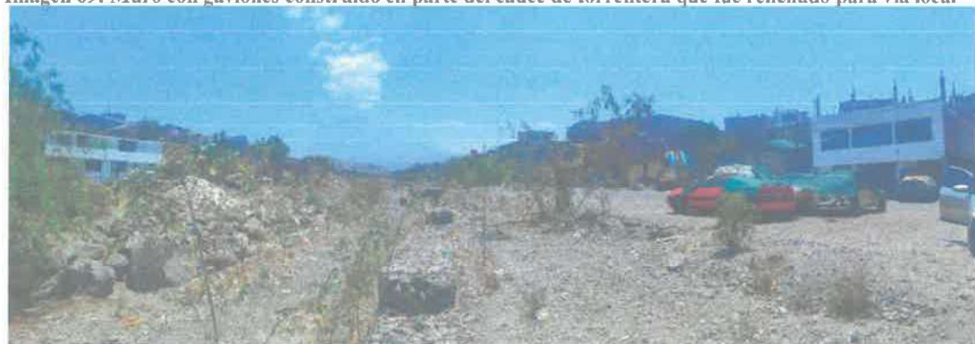
Imagen 69: Muro con gaviones construido en parte del cauce de torrentera que fue rellenado para via local
