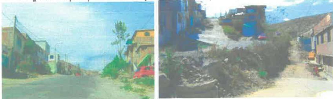
Imagen 47: Vía principal de Juan XXIII y viviendas ubicadas por debajo del nivel de la vía
