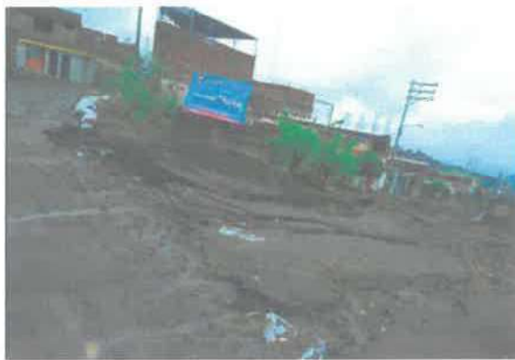
Afectación de vías de las partes altas del distrito de Miraflores
