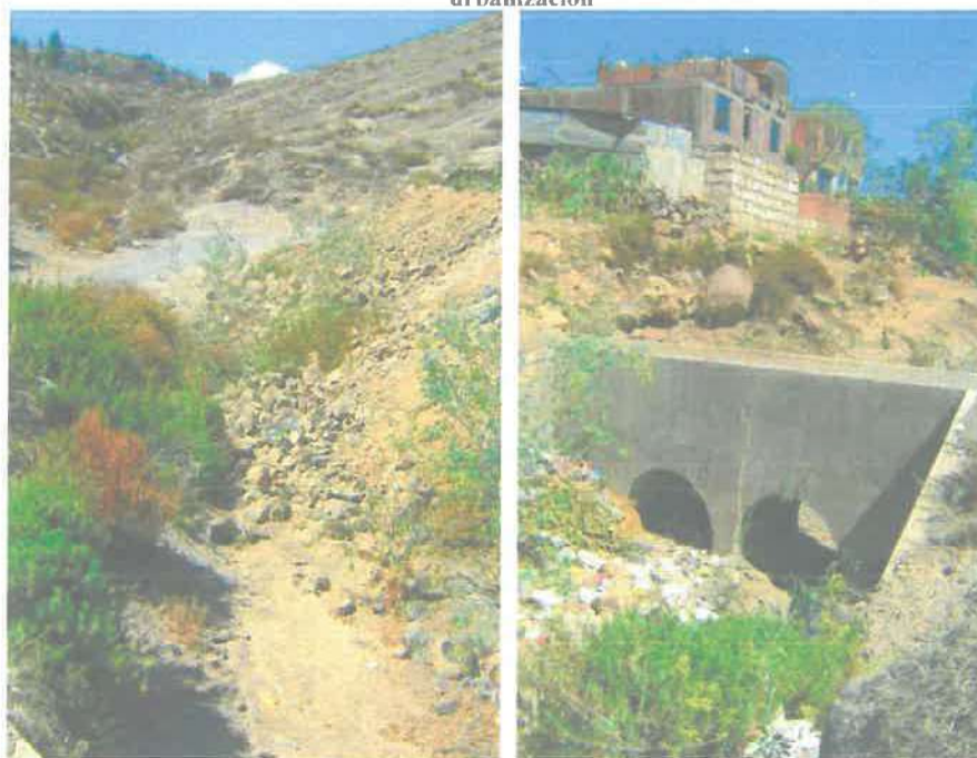
Imagen 45: Quebrada interrumpida por la vía vehicular y pontezuelo peatonal que dan acceso a la urbanización
