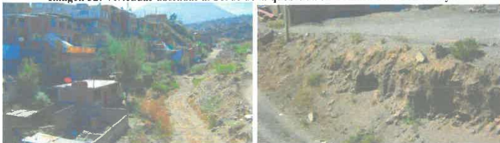
Imagen 32: Viviendas ubicadas al borde de la quebrada en Tomasa Tito Condemayta
