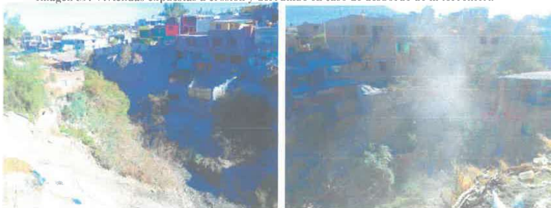
Imagen 59: Viviendas expuestas a erosión y derrumbe en caso de desborde de la torrentera
