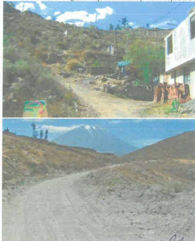
Imagen 43: Cerro desde donde se originan desprendimientos y vía susceptible a erosión
