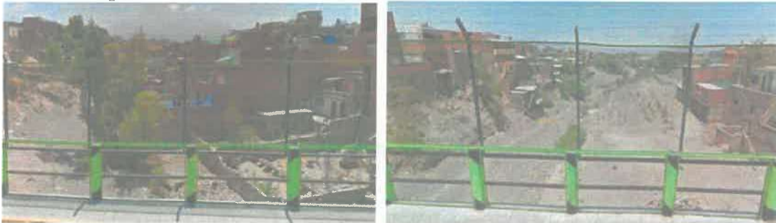
Imagen 61: Construcciones asentadas en el cauce o al mismo nivel de la torrentera
