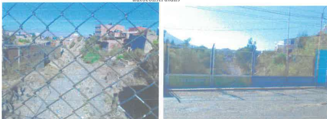
Imagen 64: Estado del cauce de la torrentera a la altura del puente de la Amistad, con invasión de viviendas autoconstruidas
