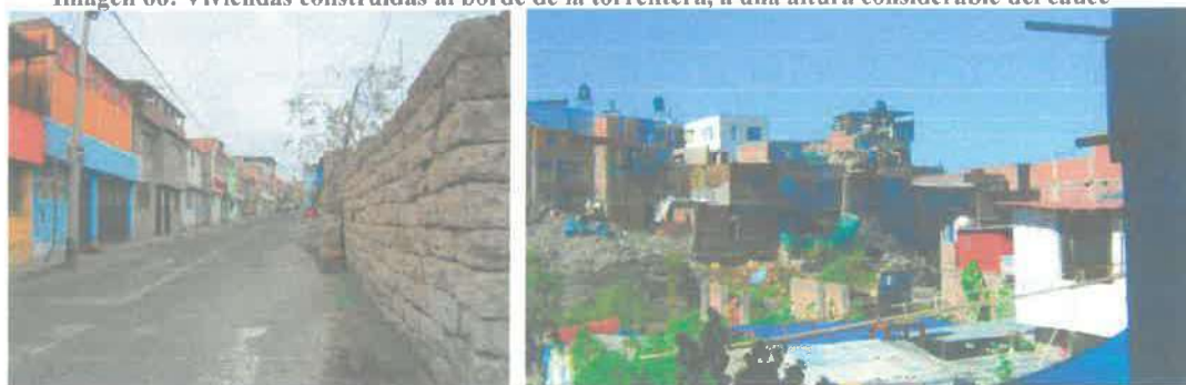
Imagen 66: Viviendas construidas al borde de la torrentera, a una altura considerable del cauce
