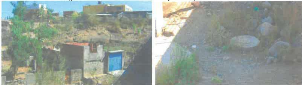
Imagen 31: Viviendas ubicadas en la quebrada, Luceros del Misti
