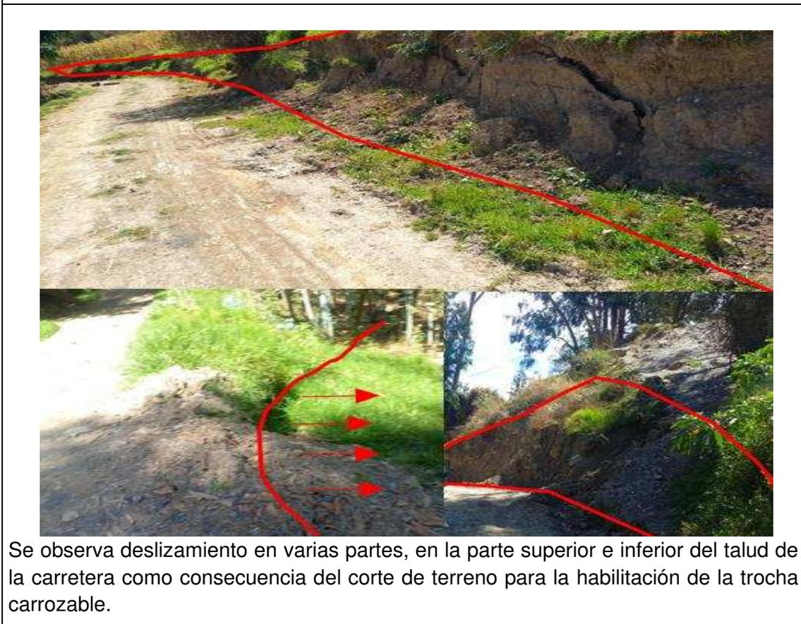
Se observa deslizamiento en varias partes, en la parte superior e inferior del talud de la carretera como consecuencia del corte de terreno para la habilitación de la trocha carrozable.
