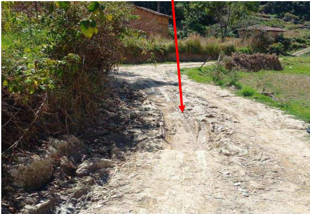
se evidencian indicios de afectación por inundación, atribuibles a la acumulación de agua pluvial en las zonas altas del tramo vial.
