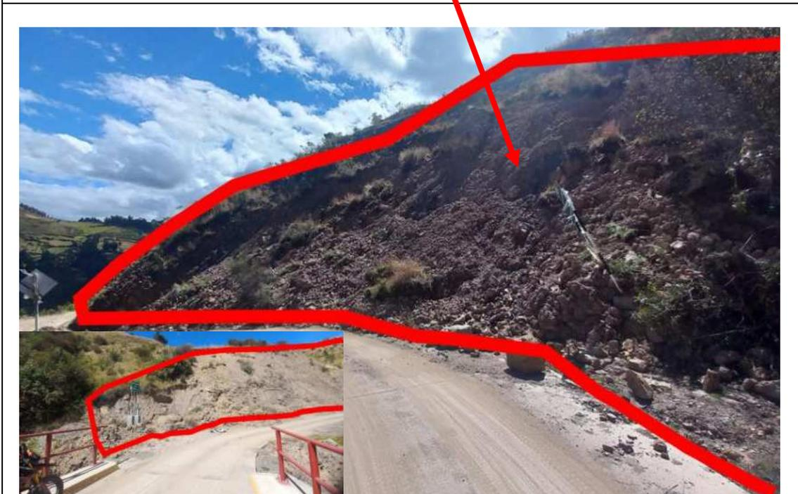
se observa deslizamiento en ambas partes de la quebrada Huajancu como consecuencia del corte de terreno para la habilitación de la trocha carrozable.
