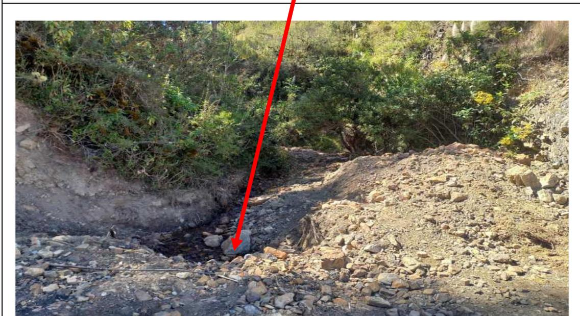
Se observa derrumbe en el talud superior de la carretera y en la derecha de la quebrada. Además, se observa restos de flujo de detritos provocado por la saturación de los suelos en la parte alta de la quebrada.
