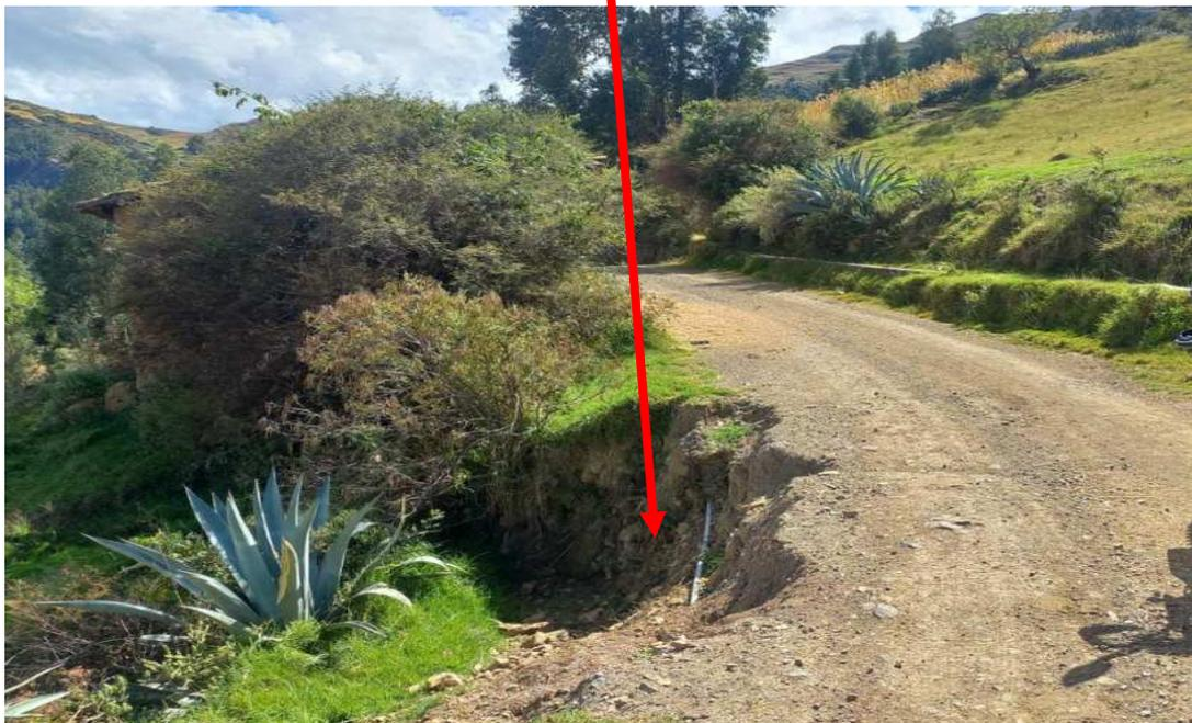
Se observa deslizamientos en varias partes de la carretera (talud inferior).
