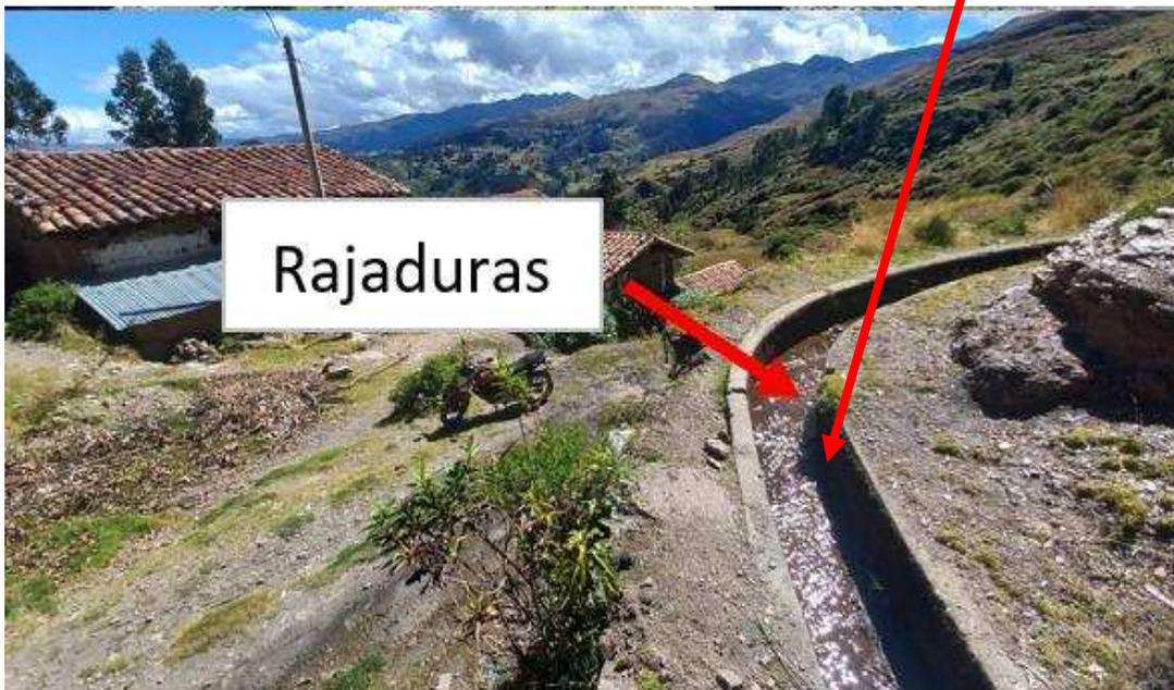
Se observa deslizamientos en la carretera y en varias partes del canal de riego debido a la acumulación de agua en la parte que filtra en la parte baja y taludes inestables.
