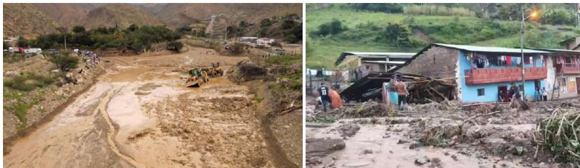
Fotografía 3. Ejemplo de flujo de lodo en el distrito de Contumazá (izquierda) y un flujo de detritos en el distrito de Choropampa (derecha).
