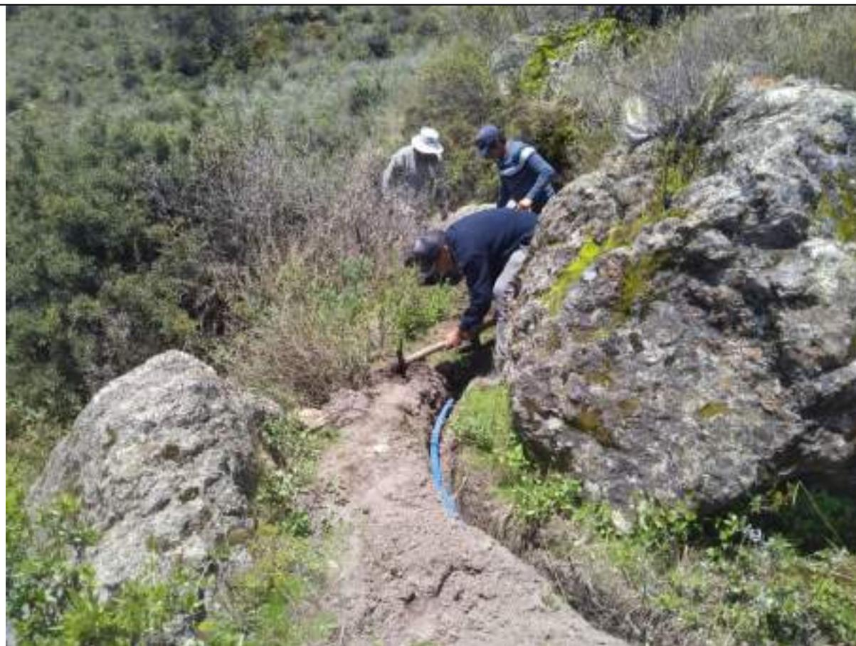
Se visualiza la instalación de tuberías hdp temporalmente para rehabilitar el servicio
