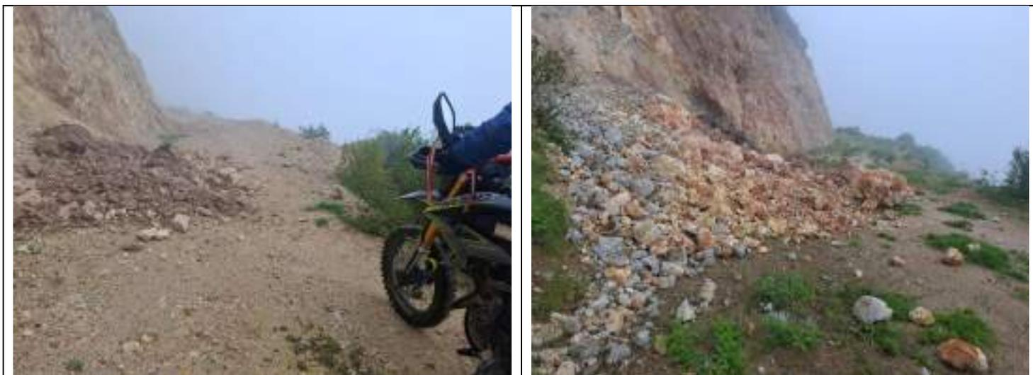
Los daños en la vía vecinal con caídas de taludes y piedras a la plataforma
