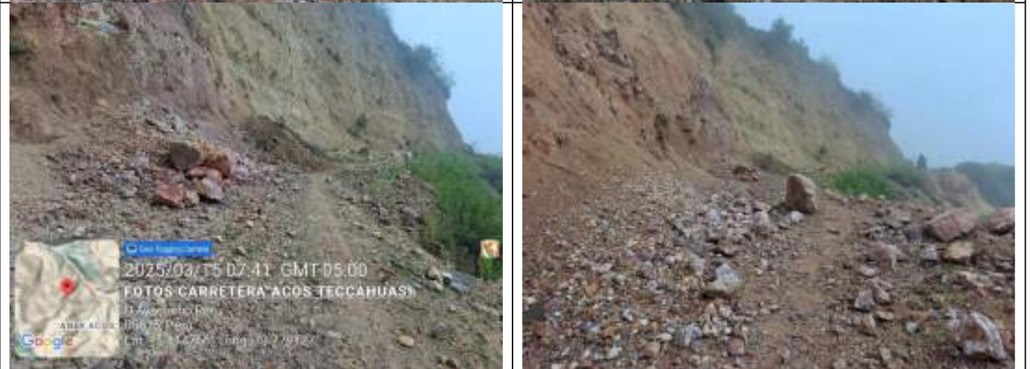
Los daños en la vía vecinal con caídas de taludes y piedras a la plataforma
