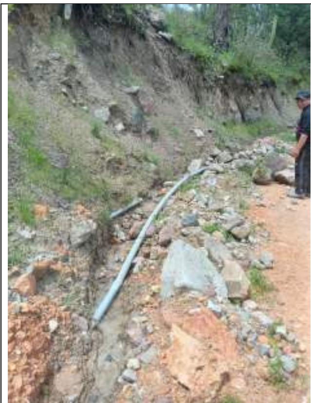
Se visualiza la tubería temporal destruido línea de aducción
