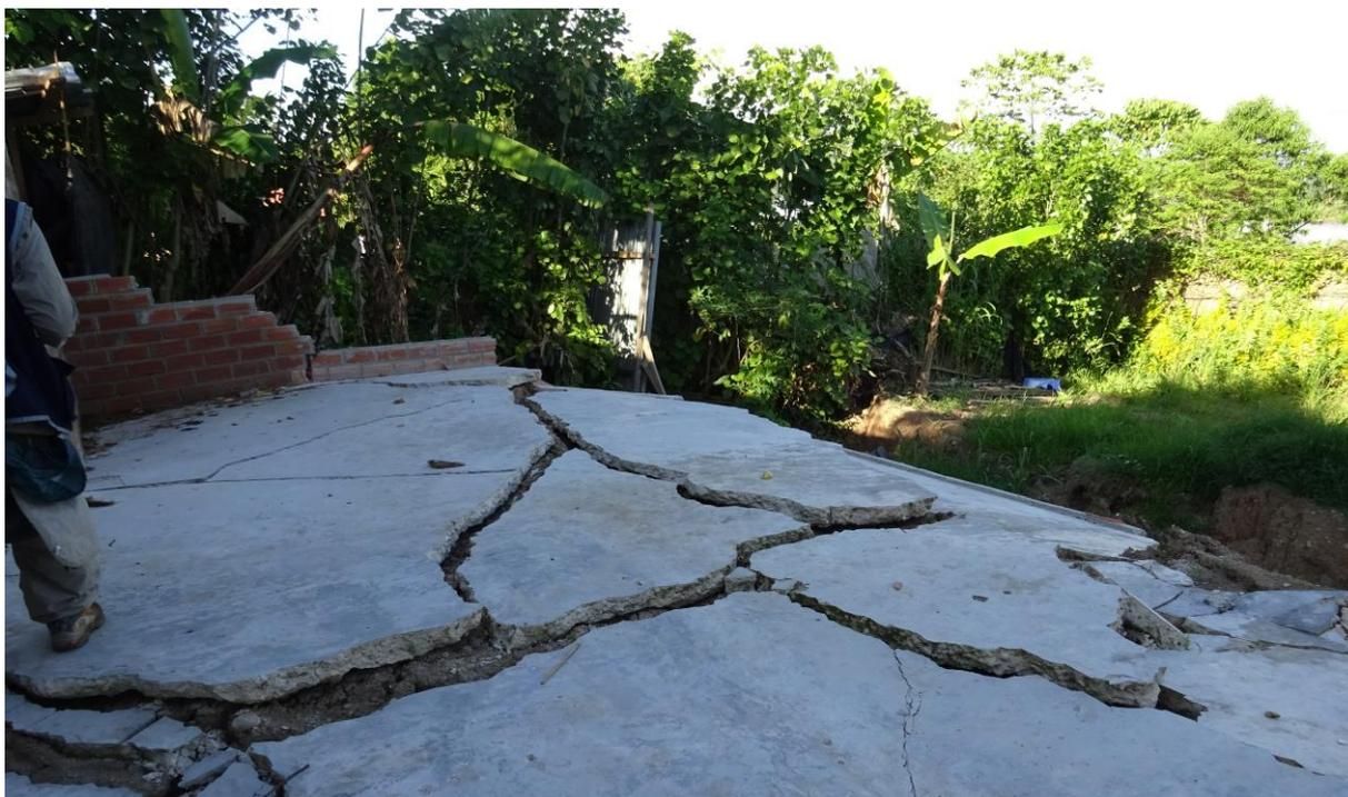
En la foto N° 01 se puede observar una de las primeras viviendas en desplomarse el año 2014, al aparecer las primeras grietas en el piso de las viviendas.
