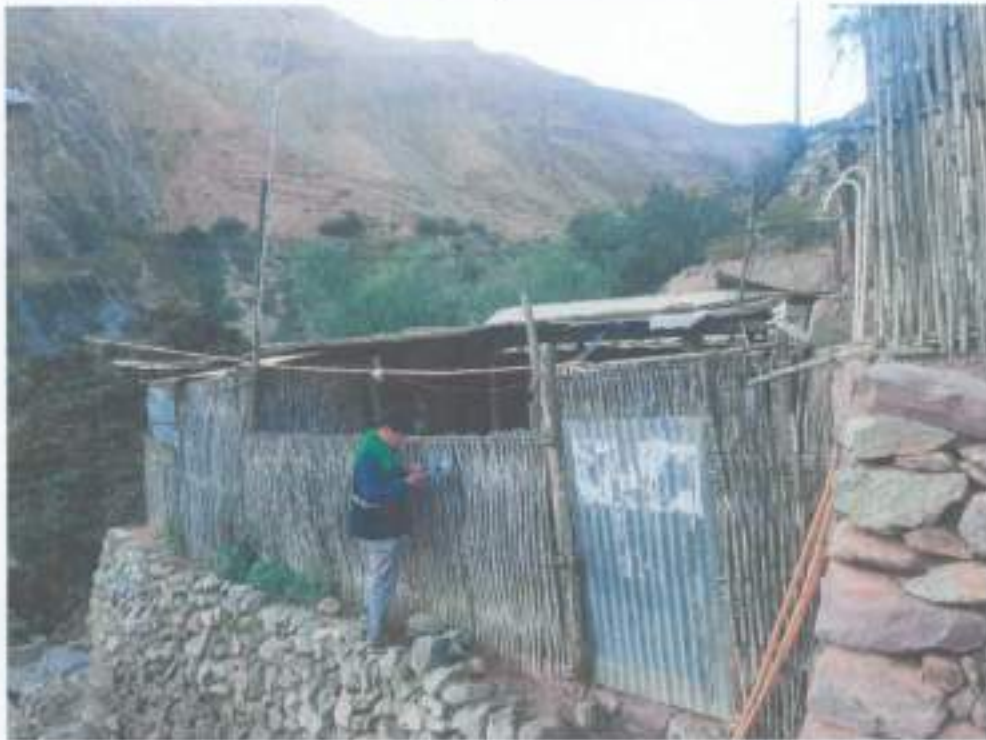
Fotografía 4 Trabajo de Campo, Vivienda de caña y techo de calamina.
