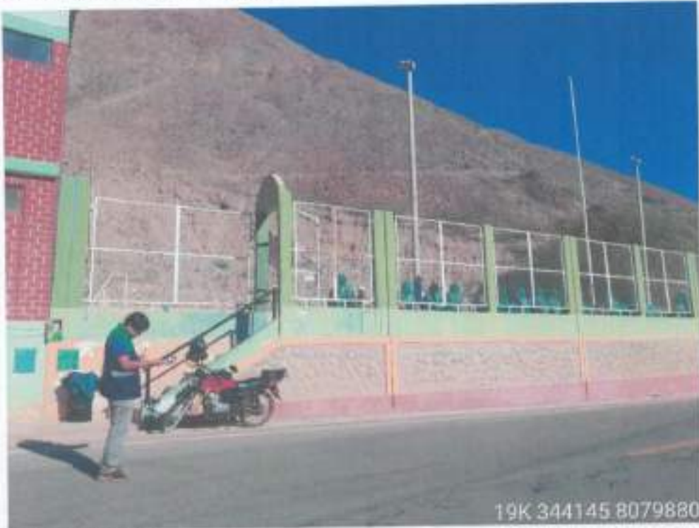
Fotografía 15 Losa deportiva de Chululuni
