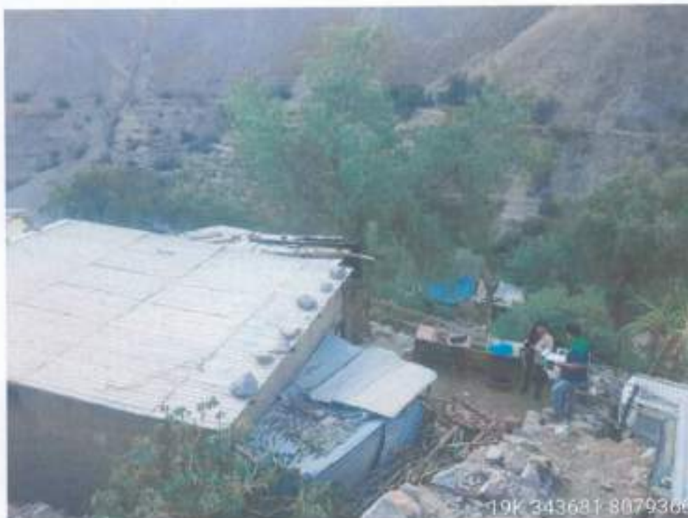
Fotografía 8 Trabajo de Campo, vivienda de adobe y calamina ubicada sobre en una plataforma inferior a la carretera a Borogueña.
