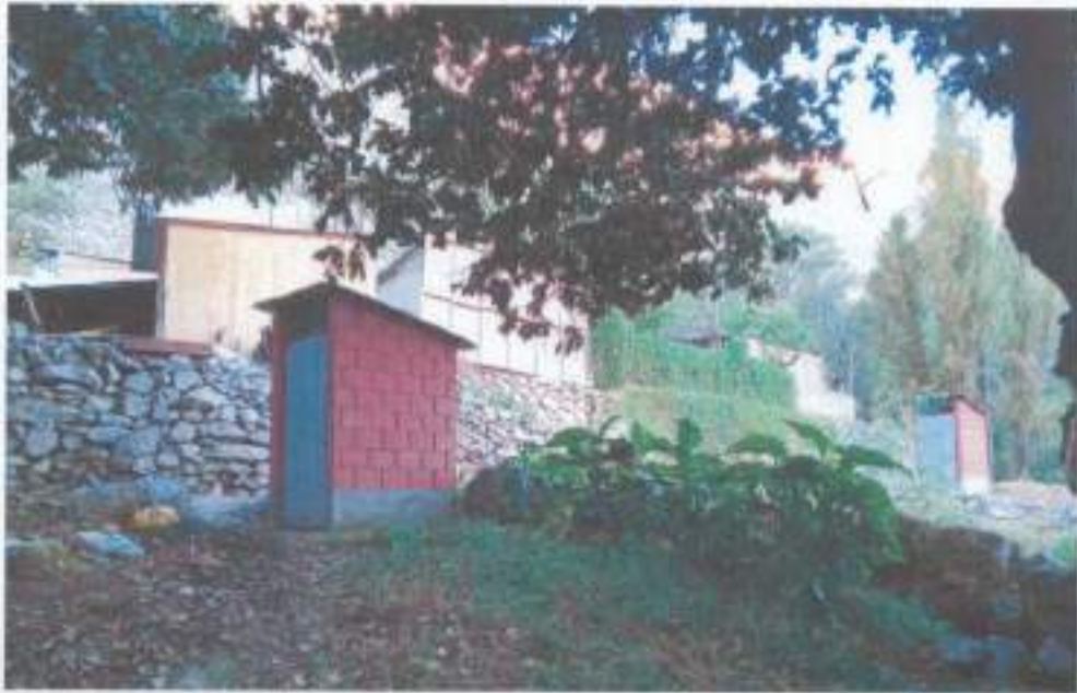
Fotografía 10 Pozo ciego/negro (letrina), ubicado en viviendas separado de los ambientes.
