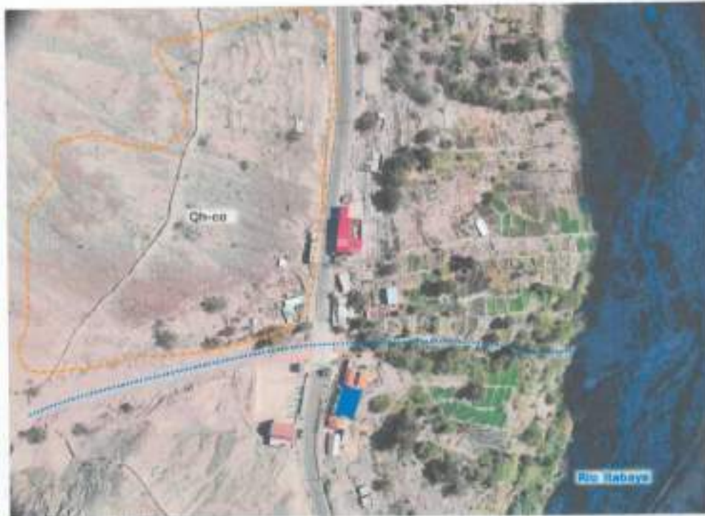
Fotografía 35 Vista de los depósitos coluviales en la vertiente de la montaña (Qh-co), en zona superior de la carretera a Borogüña.
