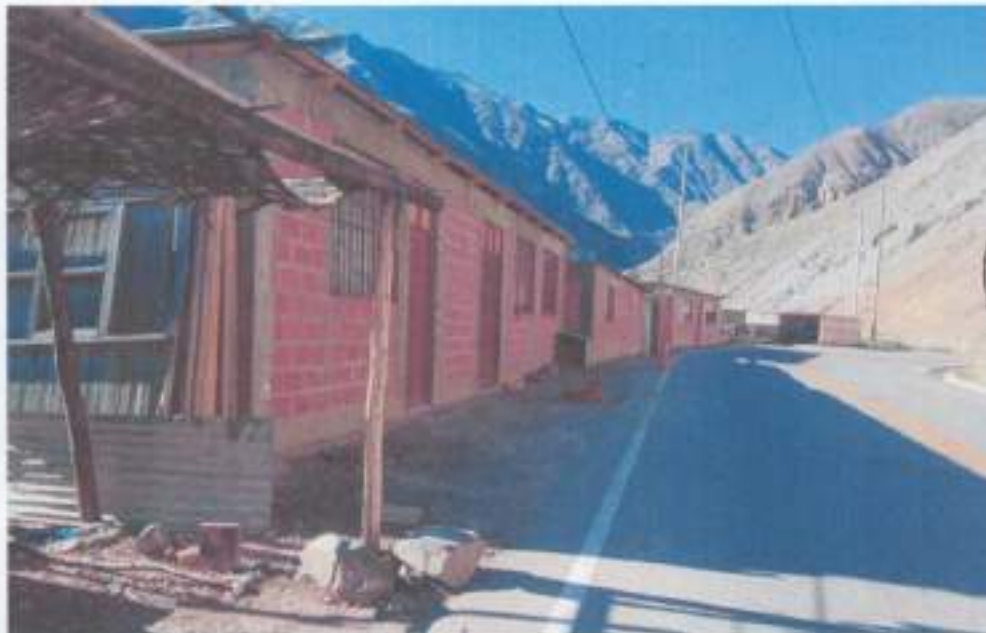
Fotografía 5 Trabajo de Campo, Viviendas ladrillo y concreto con techo de calamina, ubicadas al costado de la carretera a Borogüeña.
