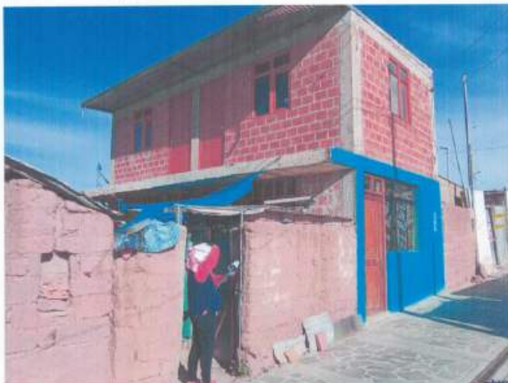
Fotografía 40 Vivienda de concreto de 2 pisos.
