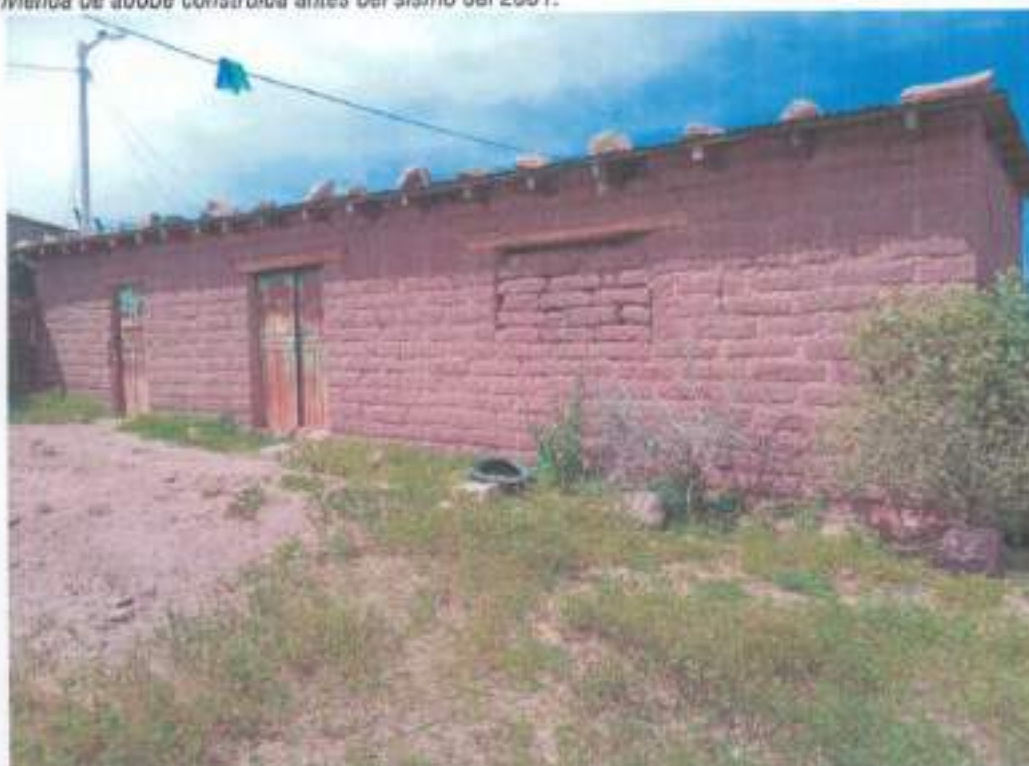
Fotografía 38 Vivienda de adobe construida antes del sismo del 2001.
