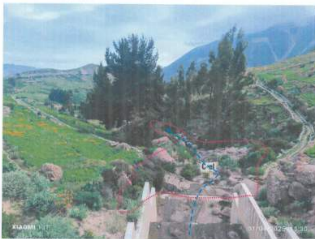
Fotografía 29 Vista del cauce aluvial (C-af), en la vertiente de roca volcánica.
