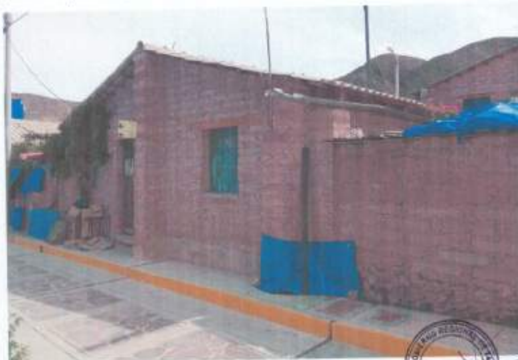
Fotografía 2 Trabajo de Campo, vivienda de adobe construida después del sismo del 2001.
