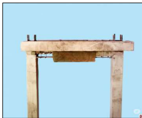
Figura 68: Reforzamiento de viga de concreto.
