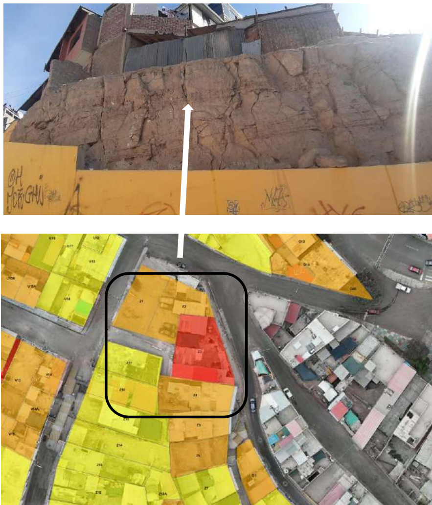
Figura 59: Vivienda en zona San Francisco en riesgo por actividad sísmica
