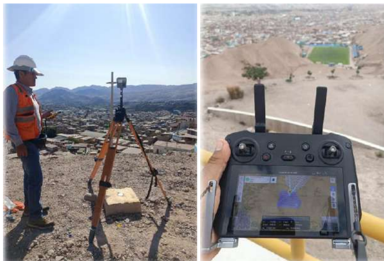
Figura 40: Trabajos topográficos en el área de estudio
