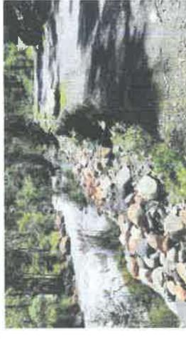
La temporada de lluvias se incrementa el caudal del río Auqui, acción que socava el margen izquierdo del río. Tal evento genera daños en la plataforma de la vía afirmada.
