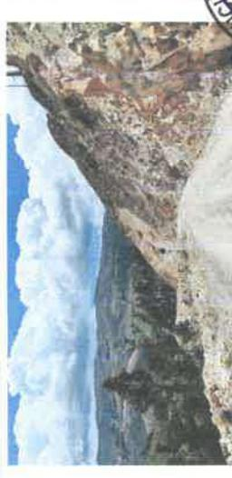
Debido a que se ha habitado una trocha carrozable hacia el Centro Poblado de Hualicor, se ha generado inestabilidad de Talud como producto del corte de terreno. Motivo por el cual se presentan deslizamientos y caída de rocas principalmente en temporada de lluvias. Estos eventos impiden el pase de los vehículos hacia el C.P. Hualicor.
