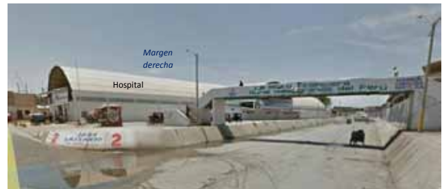
Fuente: Google Earth / Vista desde canal vía 01/14/2015
