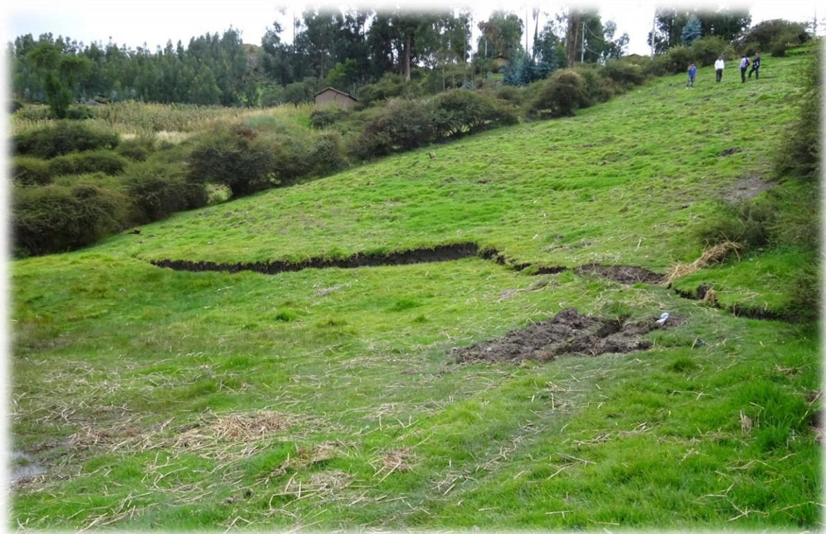
Foto N° 11: Grietas en el sector Unuhuanay.
