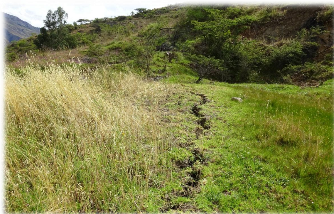
Foto N° 01: Rumbo de la grieta en el sector Alma Pampa.
