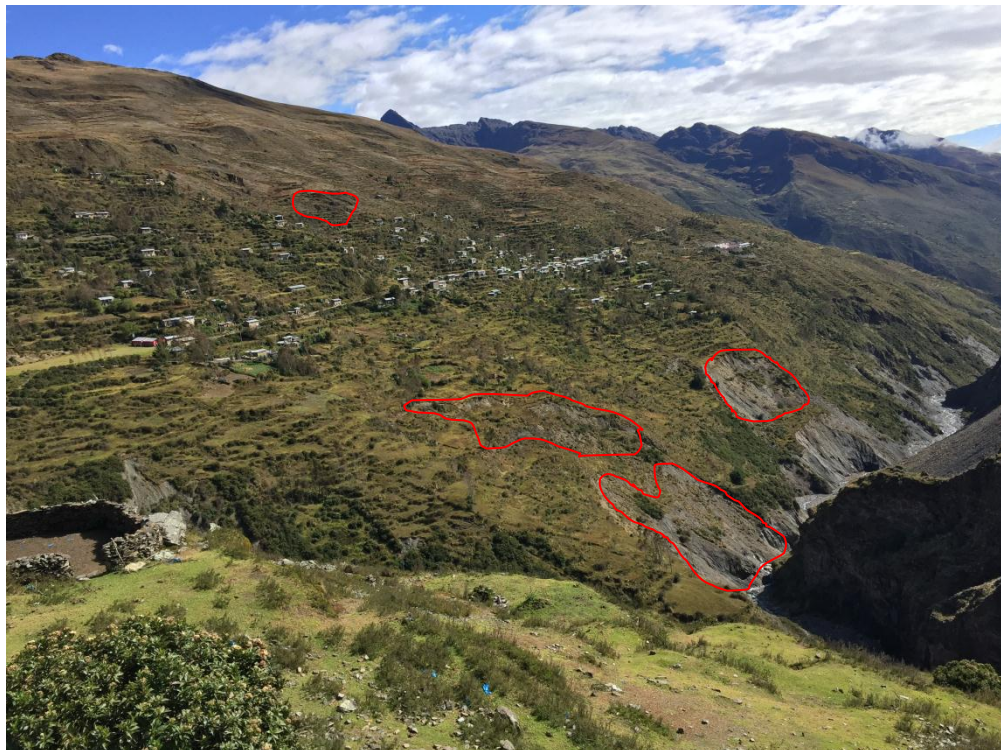
Foto N° 02: Deslizamiento que ponen en riesgo la comunidad campesina de Jarahuaña.
