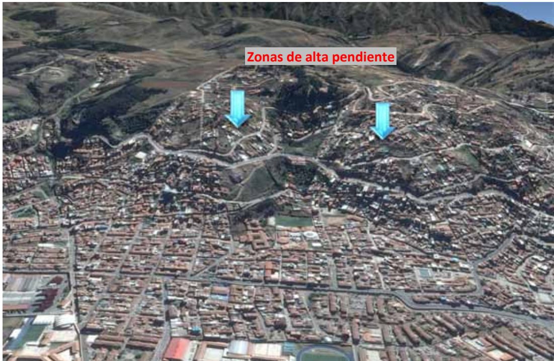
Figura 13: Zonas como Mirador, Huayracpunco, Buena Vista, Ucchullo Alto, entre otros se ubican en zona de moderada-alta pendiente. Presentan saturación, erosión durante las lluvias, discurrimiento y formación de cárcavas. La Av. Argentina y Circunvalación están expuestas a los deslizamientos o derrumbes que se puedan generar.
