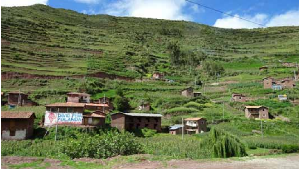
Figura 10: Viviendas de dos niveles construidas de adobe en zonas de pendiente moderada. Los suelos están compuestos de limos y arcillas cuya saturación de agua se incrementa en épocas de lluvias causando inestabilidad en las laderas de los cerros.
