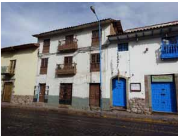
Foto 23: Viendas típicas del centro históricos de Cusco, construidas con base de Piedra y paredes de adobe, en su mayoría de dos y tres pisos. Muchas de ellas presentan fisuras en sus paredes.
