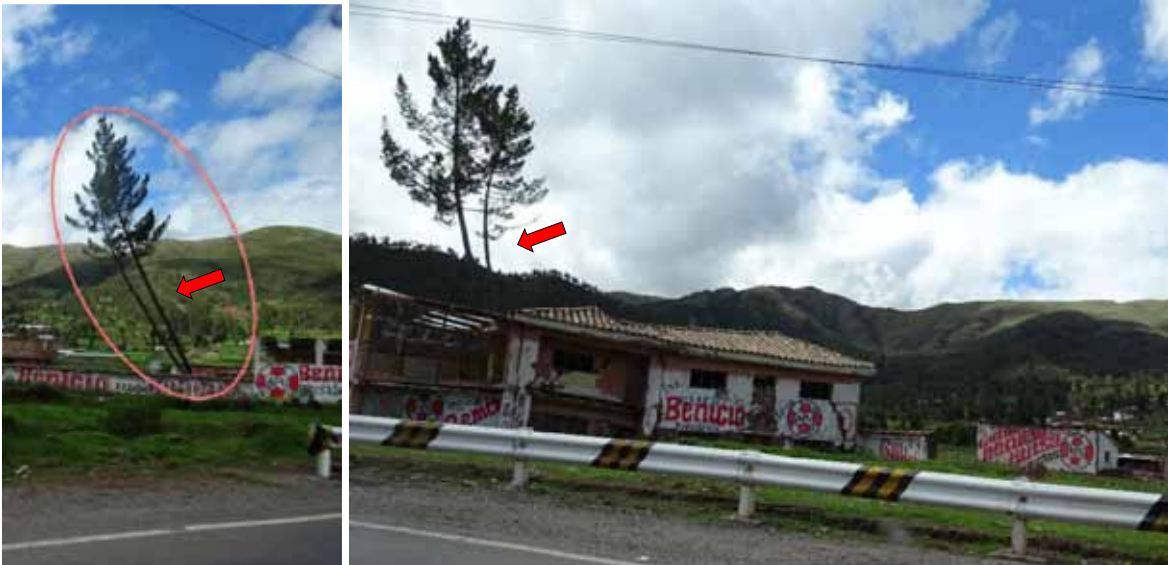
Figura 9: Viviendas ubicadas en los centros poblados de Huayllarcocha y Yucaypata. Presentan rajaduras, hundimiento y colapso. La vegetación permanente durante todo el año indica la saturación del suelo (limos-arcillas). La reptación del suelo se ve reflejado por la posición oblicua que presentan los árboles, claros indicadores de la dirección del movimiento de las masas de suelos.
