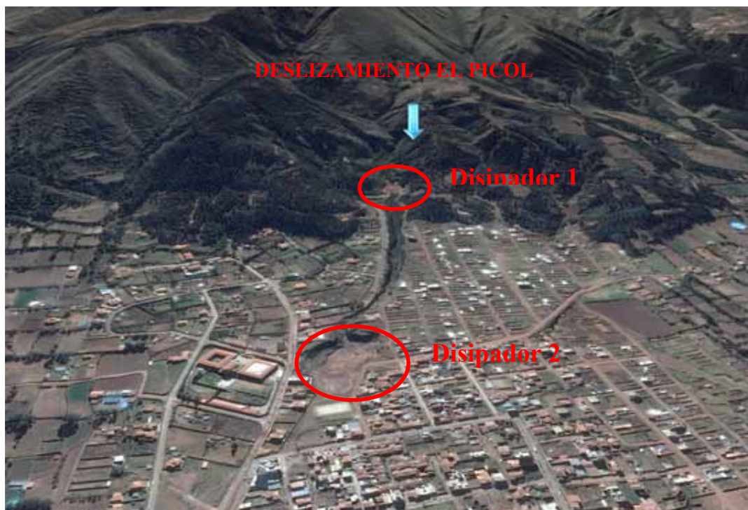
Figura 11: Deslizamiento El Picol (escarpa de aprox. 1500 m) ubicado en el cerro Huaynapicol, entre los distritos de San Jerónimo y San Sebastian. Presenta dos disipadores de energía o contenedores de flujos de detritos generados durante todo el año, principalmente durante época de lluvias intensas.
