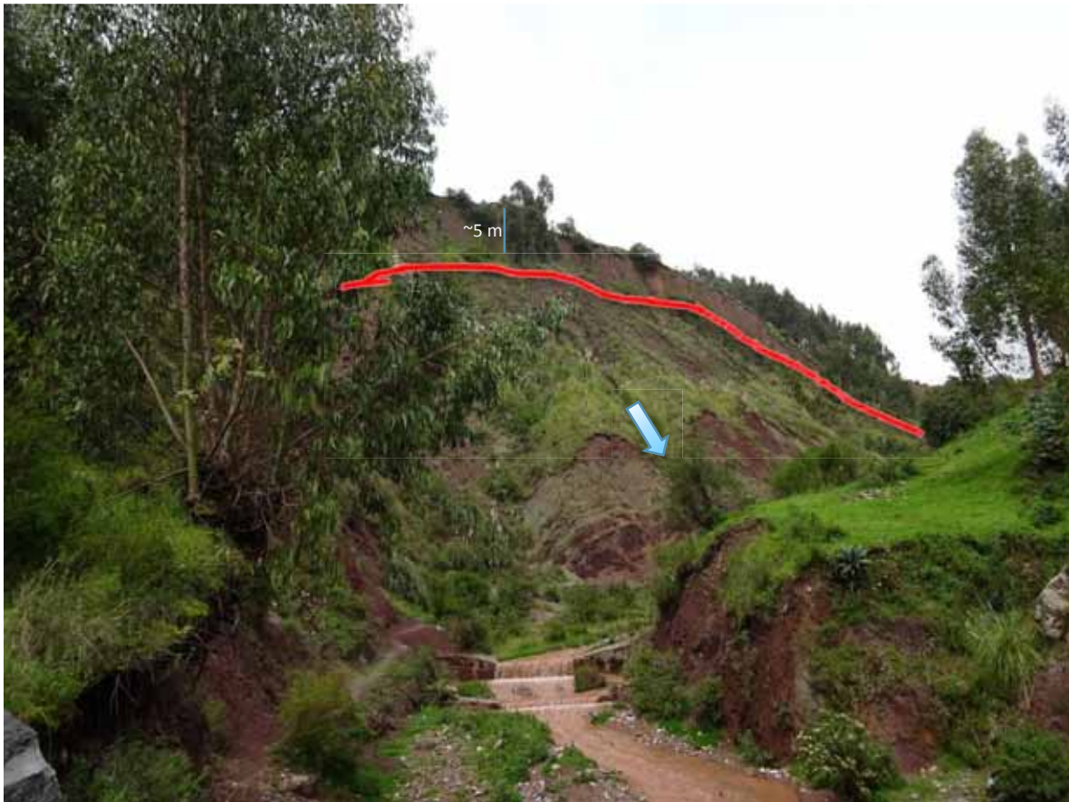
Figura 21: Deslizamiento de suelos limo-arcillosos, ubicado en la margen derecha del río Saphy. Presenta una cabecera de 50 m aprox. y un escarpe de falla en la corona del deslizamiento de 5 m; este podría ocasionar embalsamiento del río en periodos de lluvias intensas.
