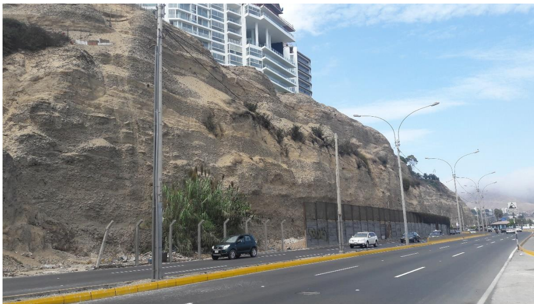
Figura 1. Vista panorámica de los acantilados del distrito de Barranco.
