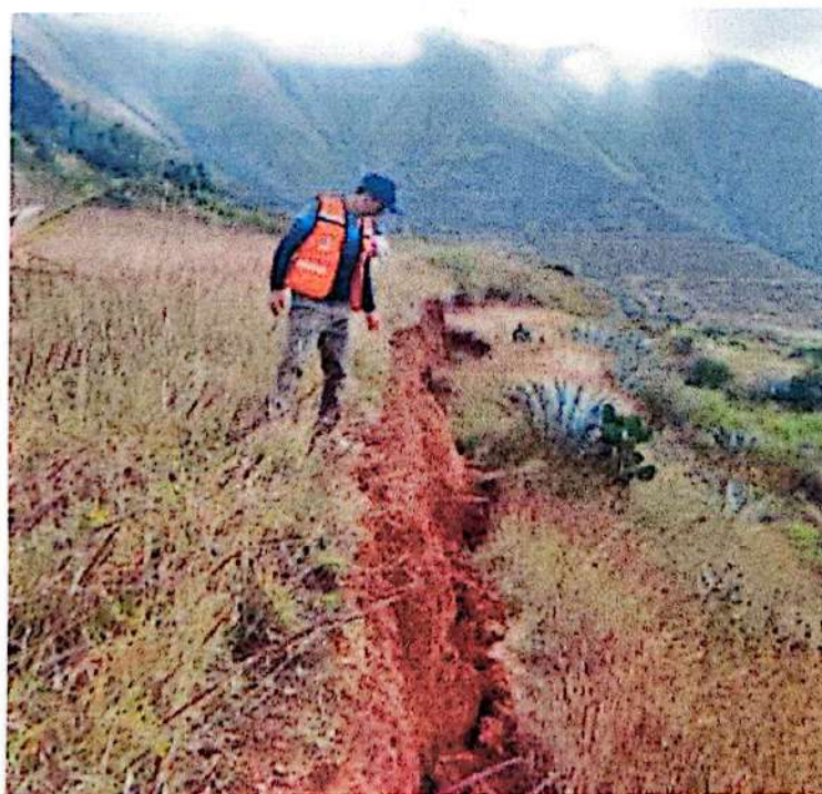
Vista N. 16: Se observa la zona crítica identificado por peligro de deslizamiento. Esta condición de peligro ha sido registrada y descrita en la Ficha Técnica PD-15.
