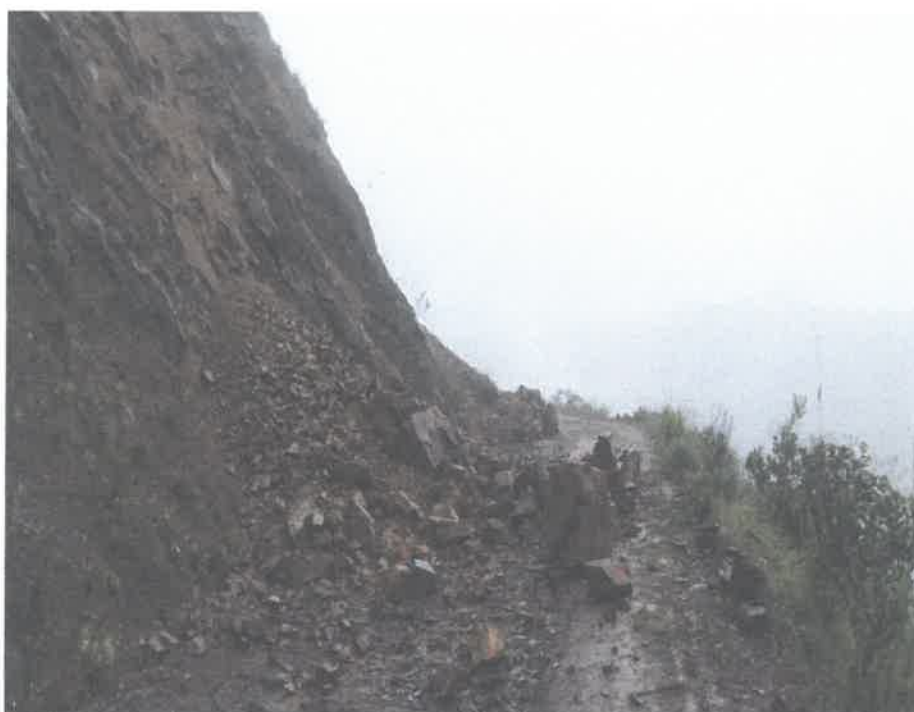
Vista N. 09: Se observa que, como consecuencia de un deslizamiento de talud, se produjo la obstrucción de la transitabilidad, afectando directamente a la población.
