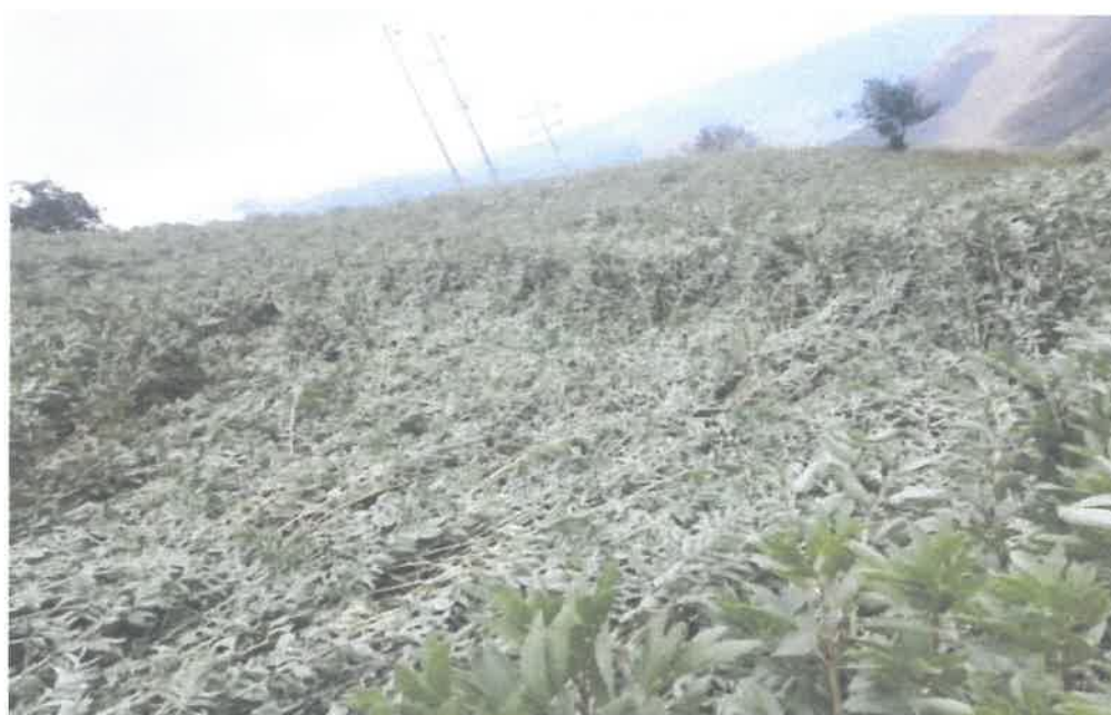
Vista N. 06: Se observa la zona crítica identificado por peligro de deslizamiento. Esta condición de peligro ha sido registrada y descrita en la Ficha Técnica PD-03.
