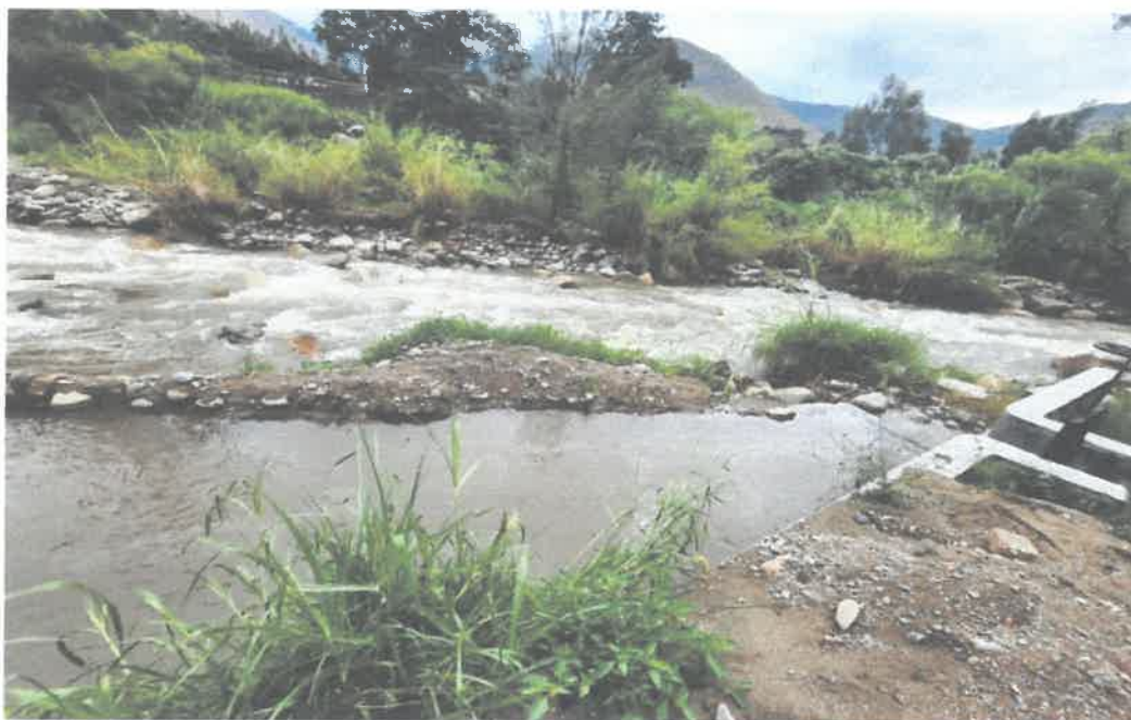
Vista N. 19: Se observa la crecida del río Quircan, cuya dinámica fluvial compromete la estabilidad y funcionalidad de las estructuras del canal existente. Esta condición se asocia al peligro de inundación fluvial, identificado como un factor de riesgo. registrada en la Ficha Técnica PI-01.
