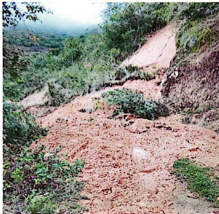
Vista N. 15: Se observa la zona crítica identificado por peligro de deslizamiento. Esta condición de peligro ha sido registrada y descrita en la Ficha Técnica PD-12.
