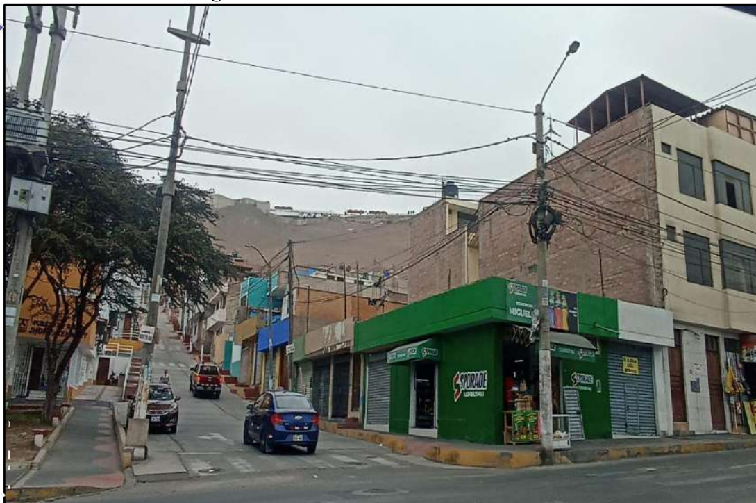
Figura N°34: Viviendas del Puerto de Ilo
