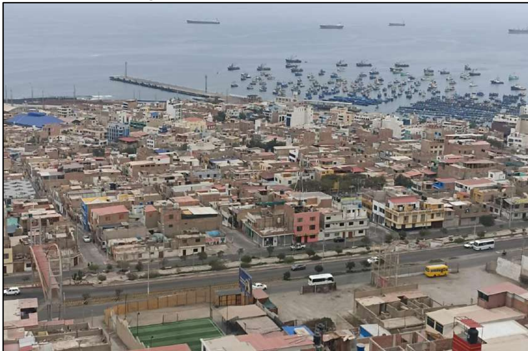
Figura N°33: Viviendas del Puerto de Ilo
