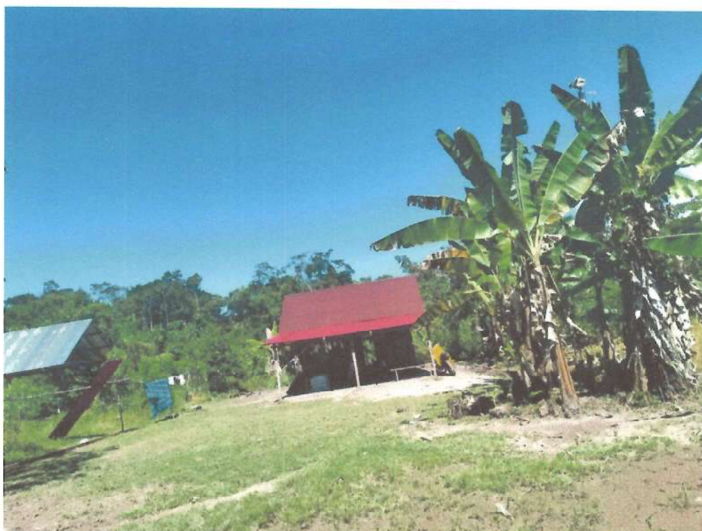
FOTOGRAFIA 08: se aprecia las infraestructuras de vivienda expuestas de la Comunidad de pampa hermosa.
