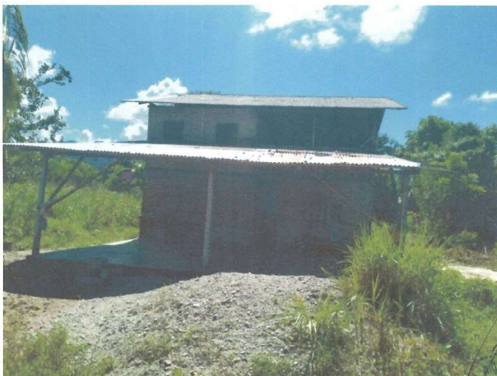
FOTOGRAFIA 07: se aprecia las infraestructuras de vivienda expuestas de la Comunidad de pampa hermosa.
