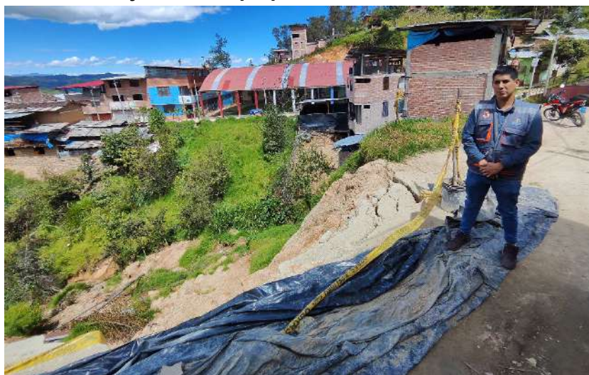
Fotografía 2. Trabajos de campo para la identificación de zonas críticas.
