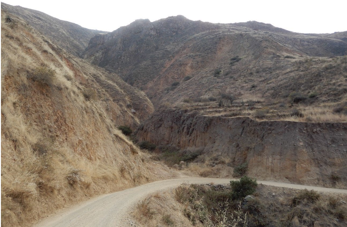
Figura 7. Imagen de cárcava que en tiempo de lluvias afecta la plataforma de la carretera, canalizando flujos de lodo y/o detritos.
