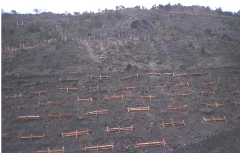
Figura 15. Distribución de biotrapas de madera, al sedimentarse estas se podrán forestar con plantas nativas para dar mayor estabilidad al talud.
