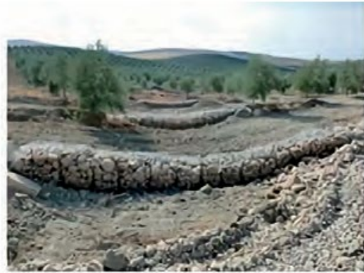
Piedra mallada (con armadura)
