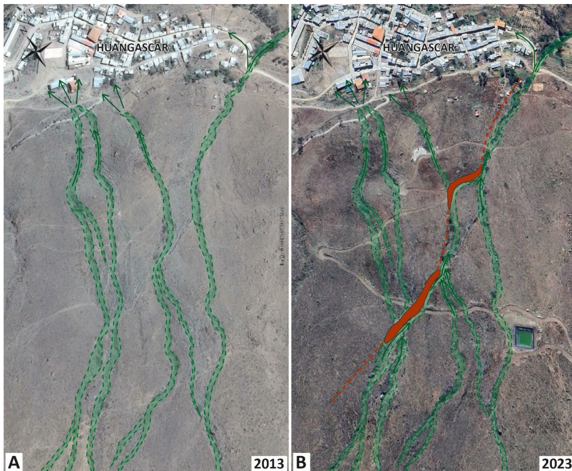
Figura 9. Cárcavas al noroeste del poblado de Huangascar. A) Proceso de carcavamamiento año 2013. B) Obras de prevención (polígono rojo), captura de cárcavas para derivar los flujos que descienden hacia el este del centro poblado, imagen año 2023.
