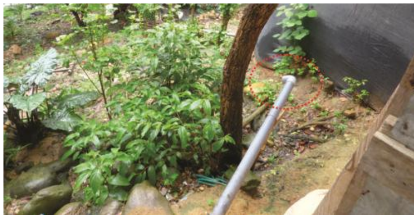
Foto 11. Se muestra el vertimiento de agua sobre la ladera.
