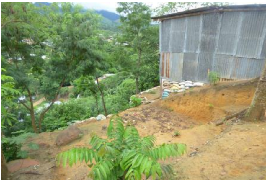
Foto 14. Sector A.V. La Victoria, se aprecia una vivienda ubicada en un talud, donde se ha nivelado (rellenado) en parte con sacos de arena, con la finalidad de uniformizar la pendiente.
