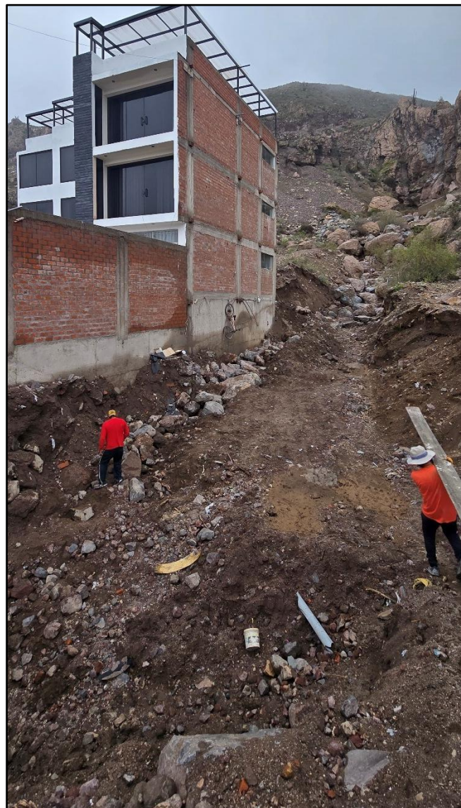
Fotografía 12. Ingreso de huaicos en el sector Villa Ecología Zona E. Alto Selva Alegre.
