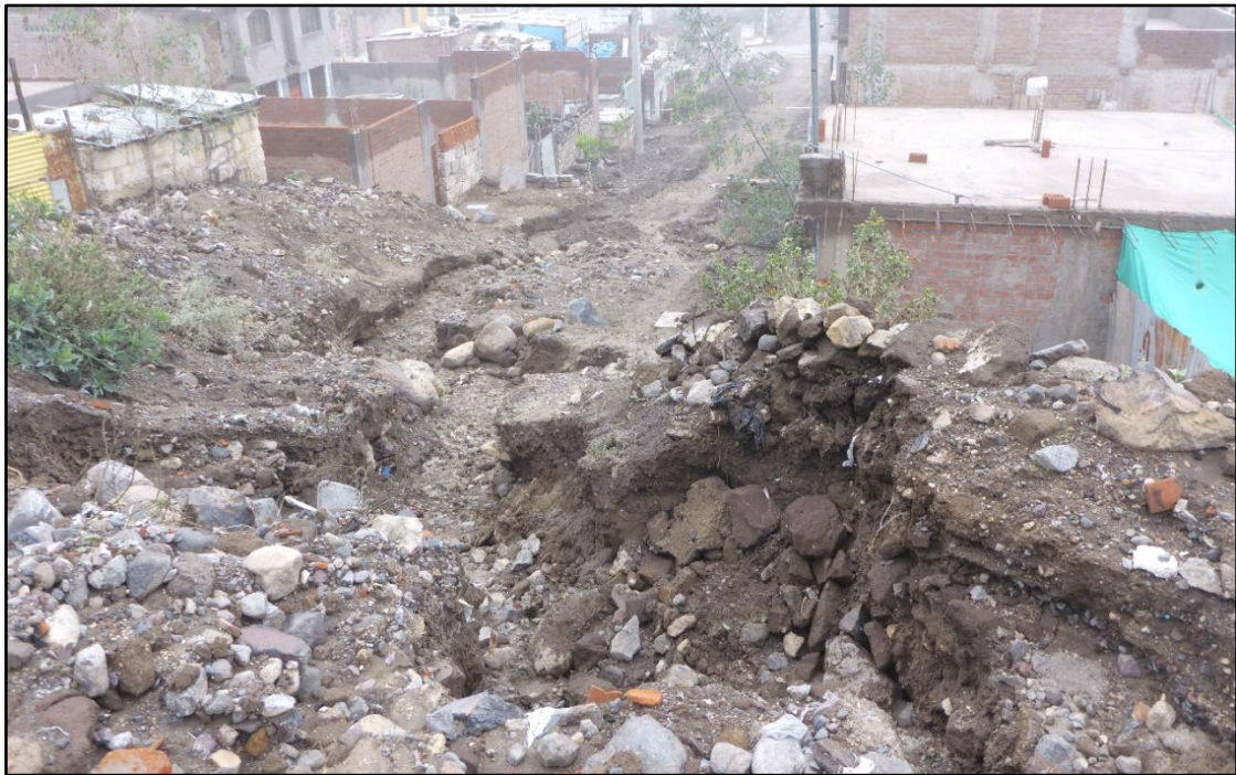
Fotografía 9. Socavamiento en las callas del sector Villa Ecológica.
