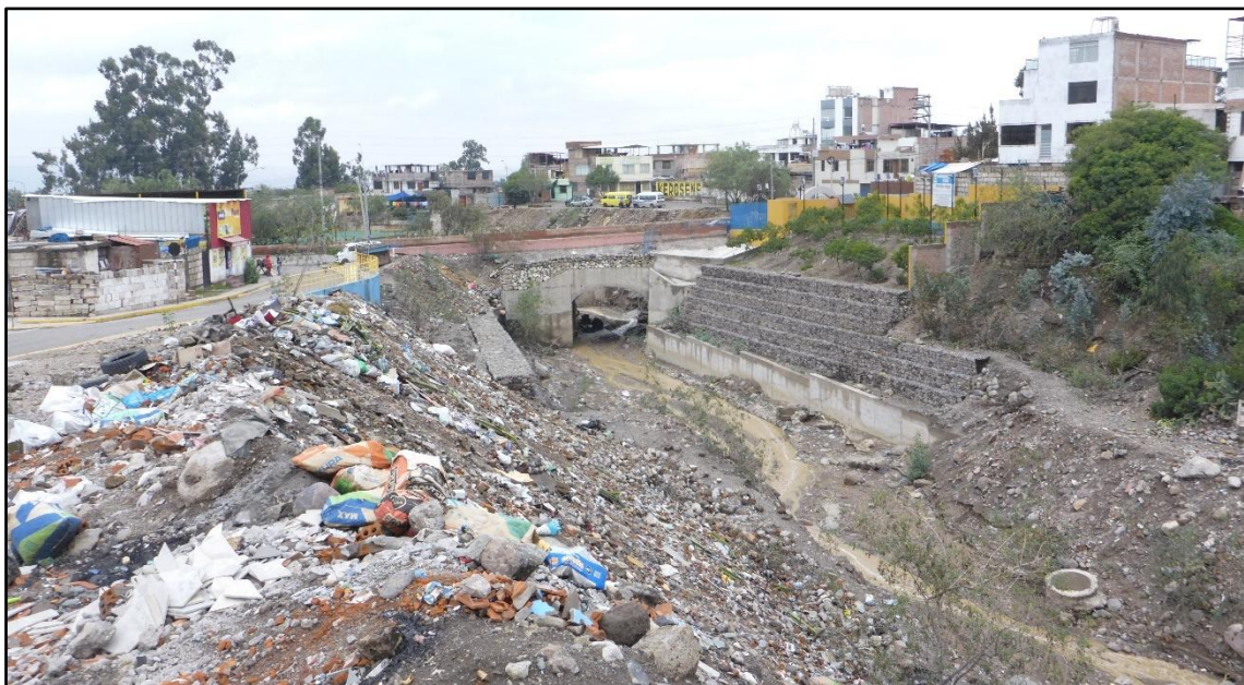
Fotografía 6. Puente ubicado en la calle Aviación, en inmediaciones del sector Azufral en el distrito Cayma.
