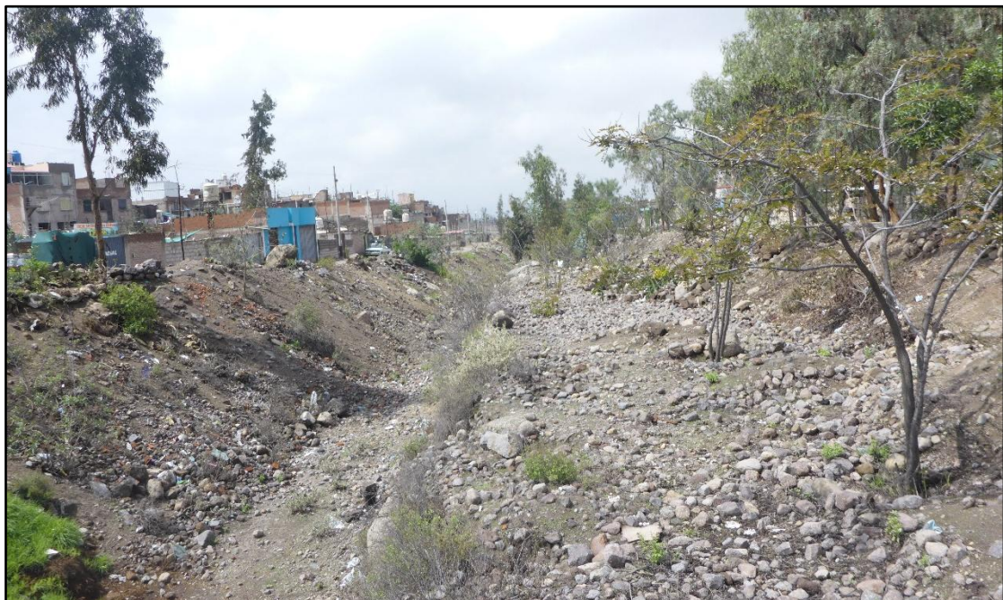
Fotografía 3. Trabajos de campo, quebrada Municipal, en el distrito Cerro Colorado.
