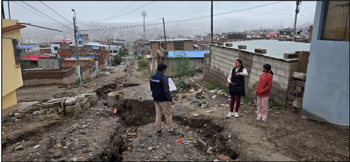
Fotografía 11. Socavamiento en las calles en el sector Y' Zona C. Alto Selva Alegre.
