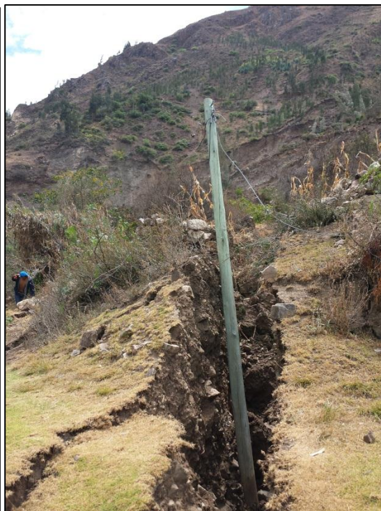
Foto 14: Grieta con apertura de 1.5m, ambas fotografías mostrando un aspecto caótico de la zona.
