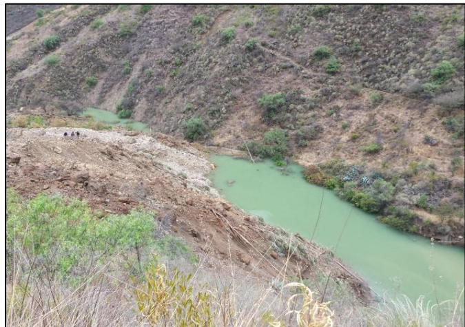
Foto 21: Represamiento producido por el deslizamiento de Tarabamba.
