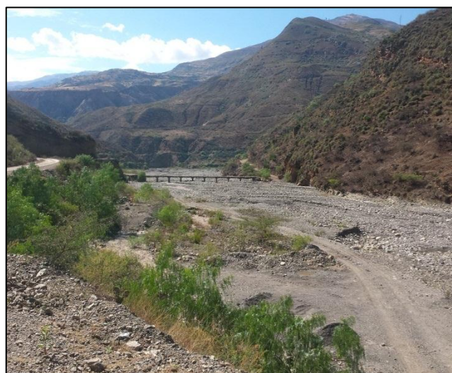
Foto 28: Puente de acceso al distrito de San Juan.
