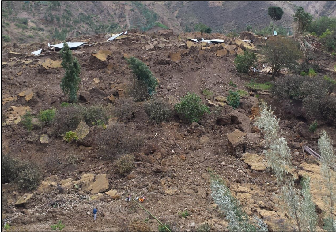
Foto 22: Aspecto caótico de la parte baja de la zona de acumulación del deslizamiento de Tarabamba.
