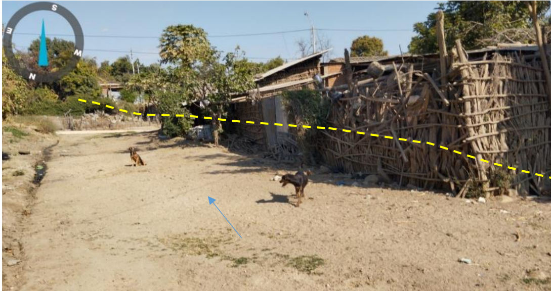
Figura 20. Viviendas ubicadas dentro del cauce de la quebrada.
