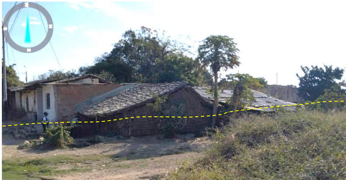
Figura 21. Viviendas inundadas durante la temporada de lluvias.
