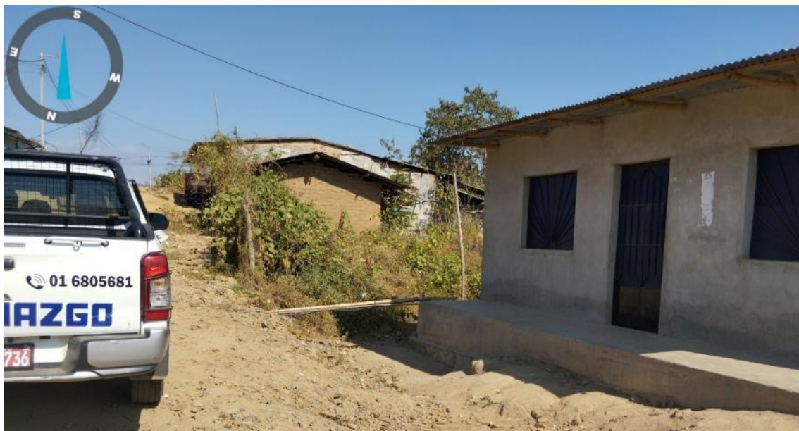
Figura 25. Calles por donde discurren los flujos de detritos, en el AA.HH. Las Palmeras.
