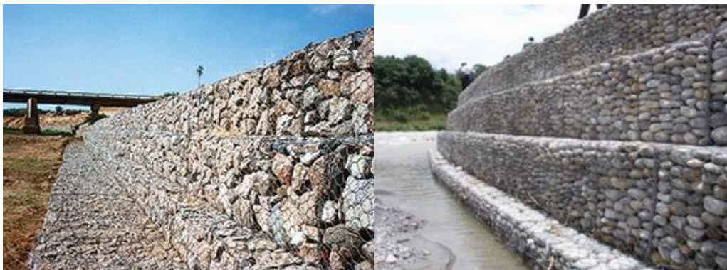
Figura 27. Defensas ribereñas gaviones de rocas. Cliente: Asociación Pataz (ONG Minera Poderosa)
