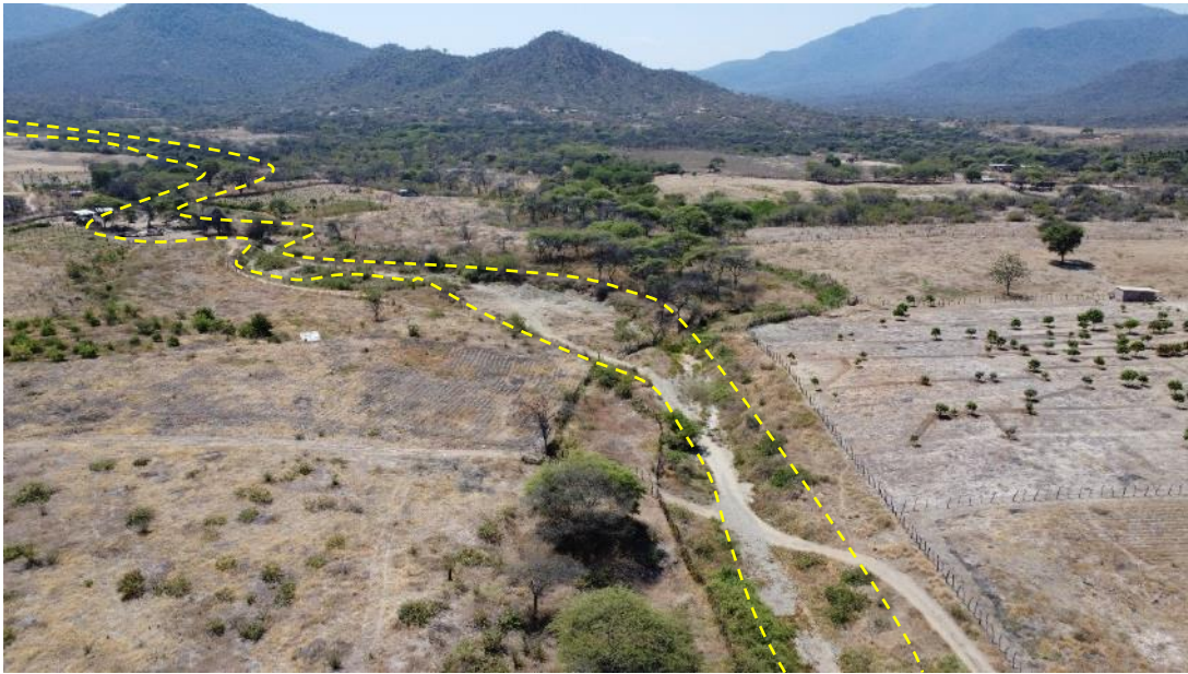
Figura 12. Cauce del río Las Lomas, denominado como Canal Vía al entrar al área urbana del distrito.
