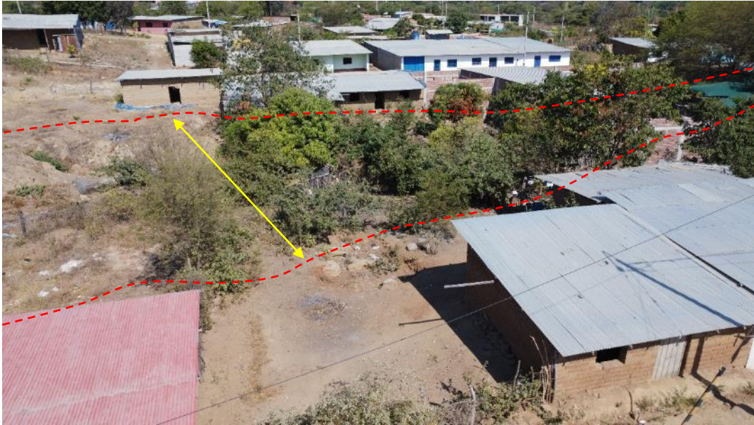
Figura 15. Cauce de la quebrada Las Palmeras con un ancho de 7 m.
