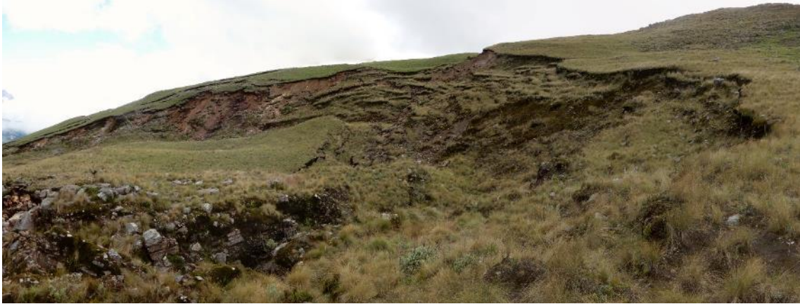
Fotografía 19. Zona de escarpe del deslizamiento D1 ubicado en la ladera media del cerro Negro. Nótese, en ancho de deformación superficial escalonado del deslizamiento. Vista panorámica mirando al norte.
