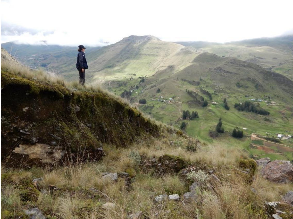
Fotografía 21. Salto prominente del escarpe principal ubicado en el flanco izquierdo del deslizamiento D1. En este sector, el salto tiene ~2 m de desnivel. Vista mirando al suroeste.
