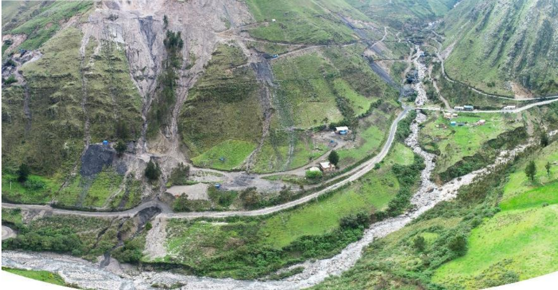
Fotografía 10. Depósitos aluviales dispuestos sobre la margen del río Huancay y depósitos fluviales a lo largo del cauce del río en el sector San Pedro. Vista panorámica mirando al noreste.
