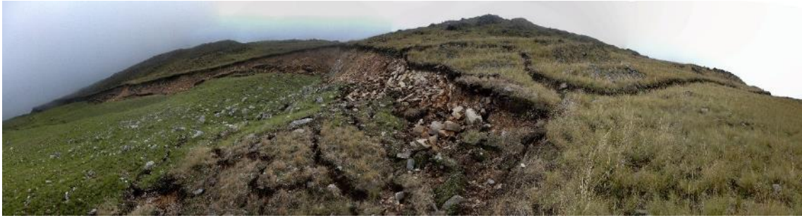
Fotografía 23. En la parte superior del deslizamiento D2, se observa el escarpe principal. En el flanco izquierdo se registra una grieta retrogresiva que se extiende sobre la ladera del cerro Negro. Vista panorámica mirando al este.
