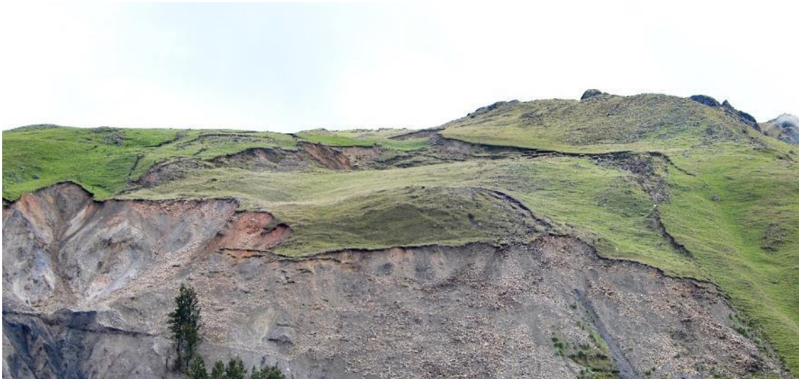
Fotografía 24. Superficie de ruptura o de arranque del derrumbe que afecta la zona distal del deslizamiento D1, ubicado en la ladera media del cerro Negro. Vista mirando al este.
