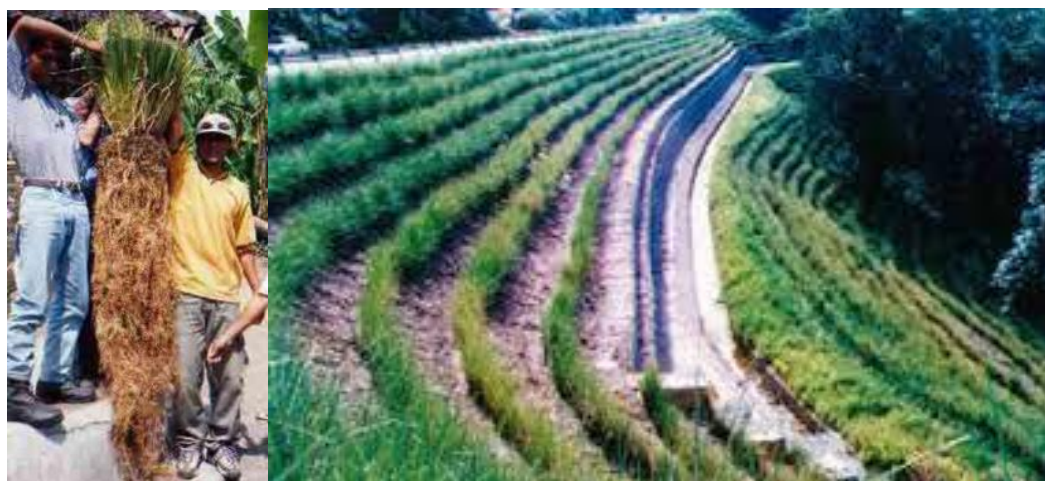
Figura 12. Ejemplo de bioingeniería con arbusto (vetiver) en taludes de materiales sueltos.
