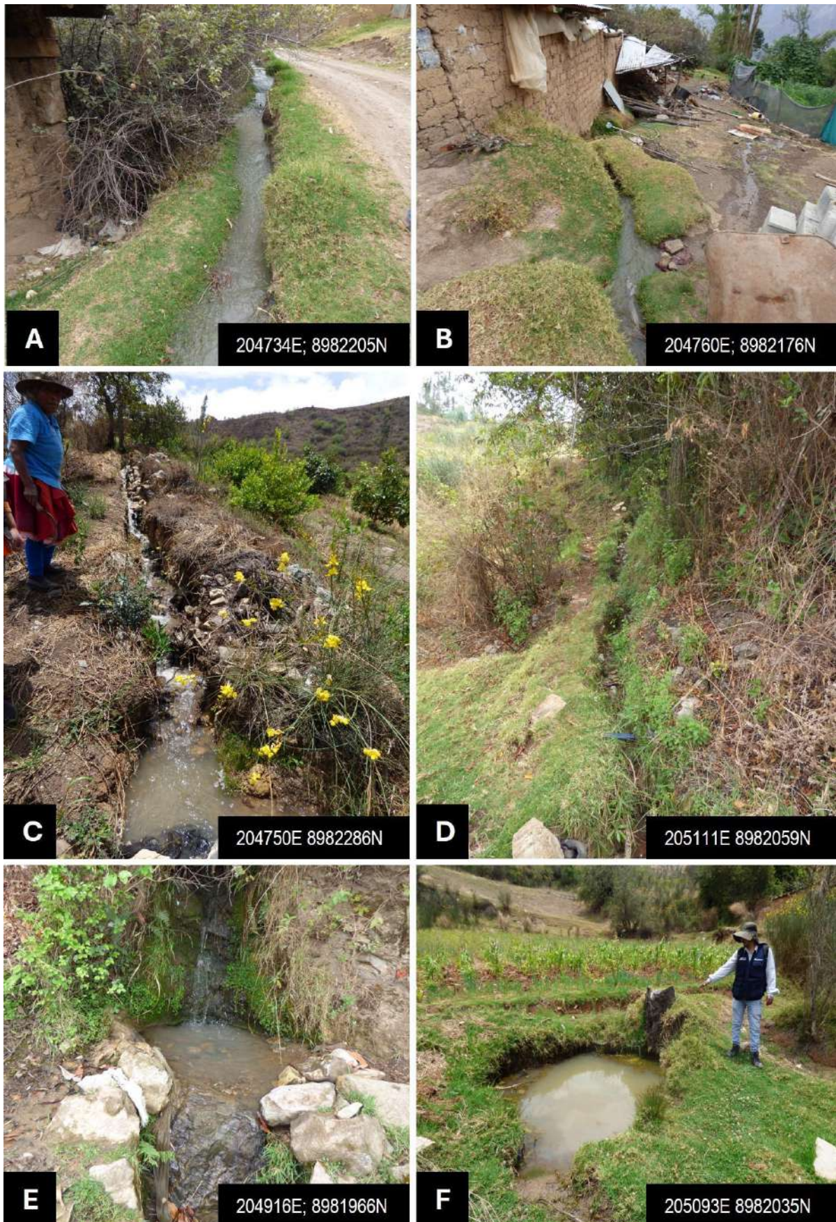
Figura 27. Vista de canales de riego no revestidos (A, B, C, D) y surgencias de agua (E, F).
