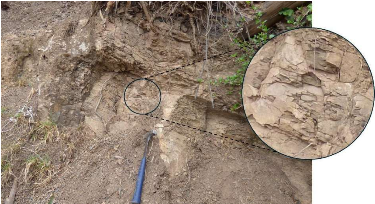
Figura 7. Vista de lutitas gruesas bituminosas intercaladas con limolitas de 5-8cm, muy fracturado y meteorizado, ubicado en las coordenadas UTM 18L 204901E; 8982006 N.
