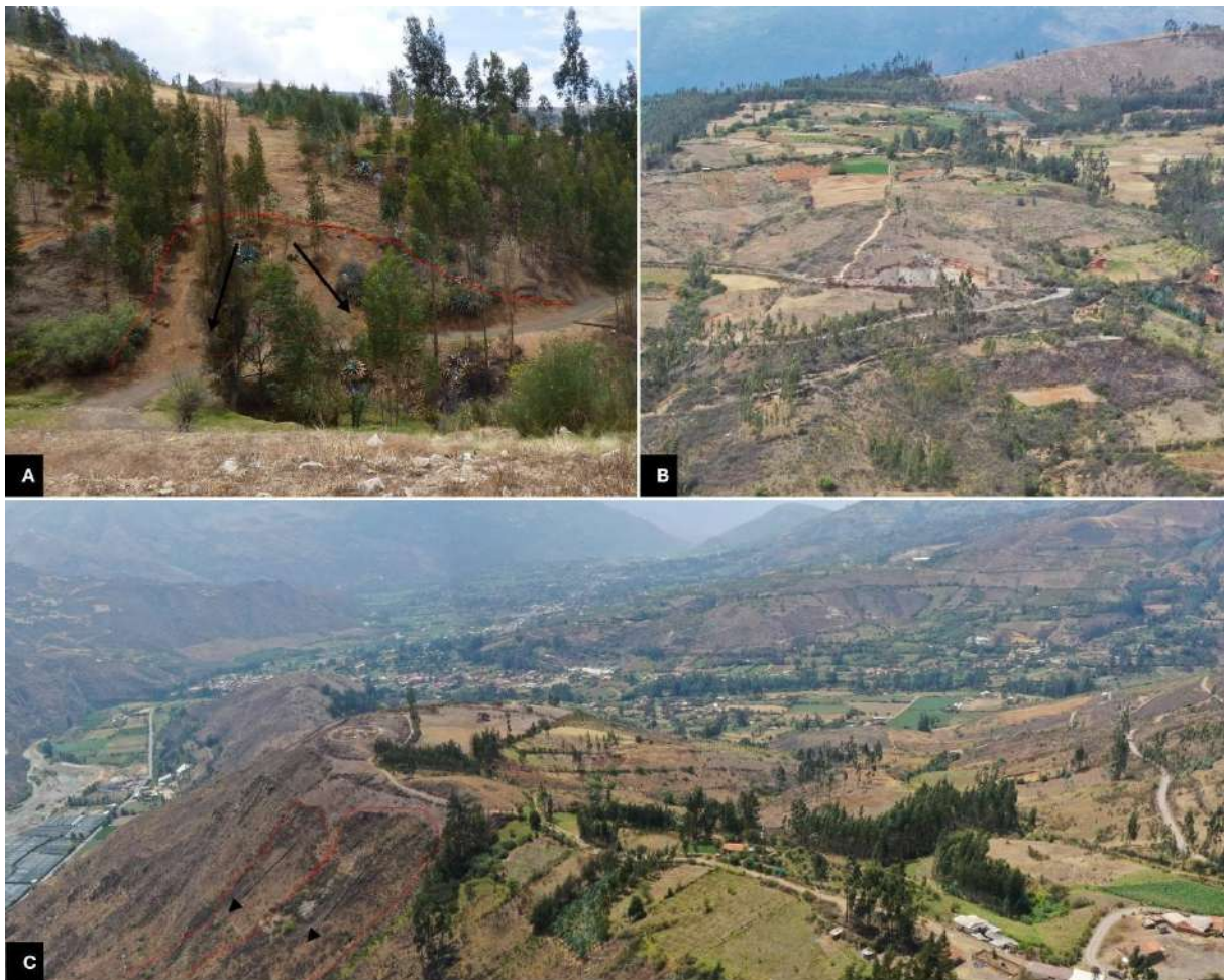
Figura 20. Derrumbes en Shoropunta (líneas rojas en la cara libre) juntos a la vía vecinal, coordenadas UTM E:205307; N:8982376 (A) y E:205215; N:8982000 (B). Hacia el suroeste del poblado, coordenadas UTM E:204562; N:8982095 (C).
