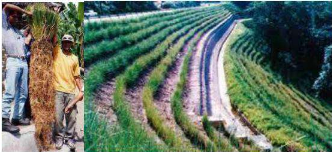
Figura 39. Ejemplo de bioingeniería con arbusto (vetiver) para reforestación de taludes inestables.
