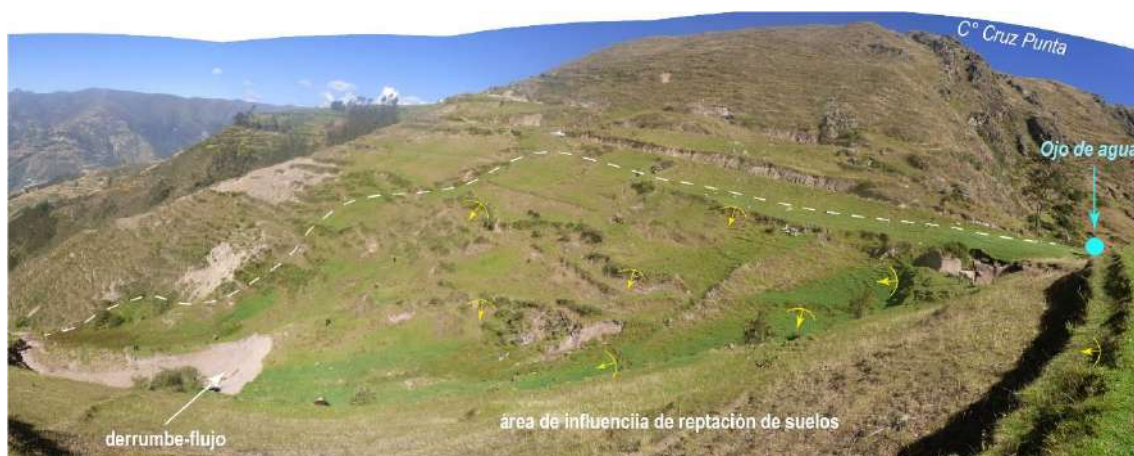
Figura 33. Reptación de suelos ubicada al norte del cerro Cruz Punta, en la parte superior del derrumbe en el sector Huayapag. Se diferencia agrietamientos discontinuos distribuidos de manera disarmónica. Vista mirando al sur.
