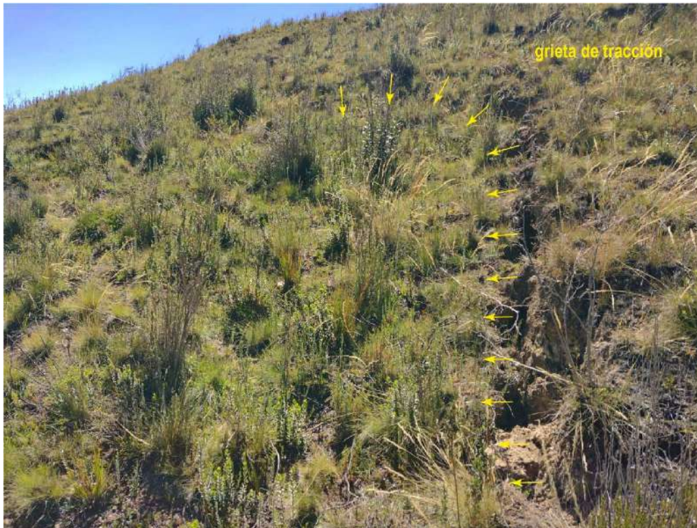
Figura 26. Grietas de tracción en la parte superior de la zona de arranque del derrumbe (D1). Se observa un salto de 30 a 40 cm con una abertura de 10 a 25 cm de ancho que se separa del suelo. Vista mirando al norte.
