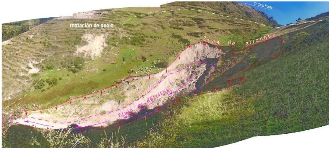
Figura 31. Zona de arranque del derrumbe y flujo de detritos al norte del cerro Cruz Punta en el sector Huayapag. Vista panorámica mirando al sur.
