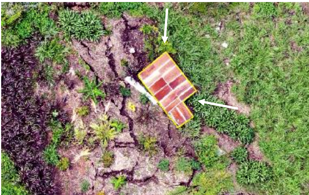
Figura 16. Vivienda afectada por el deslizamiento DA1.
