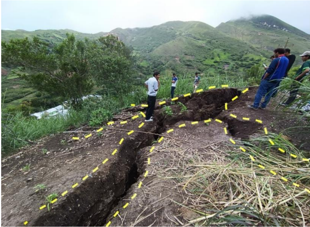
Figura 13. Agrietamientos en el deslizamiento activo – DA1. Coordenadas UTM WGS84 17M. 770987, 9323389.
