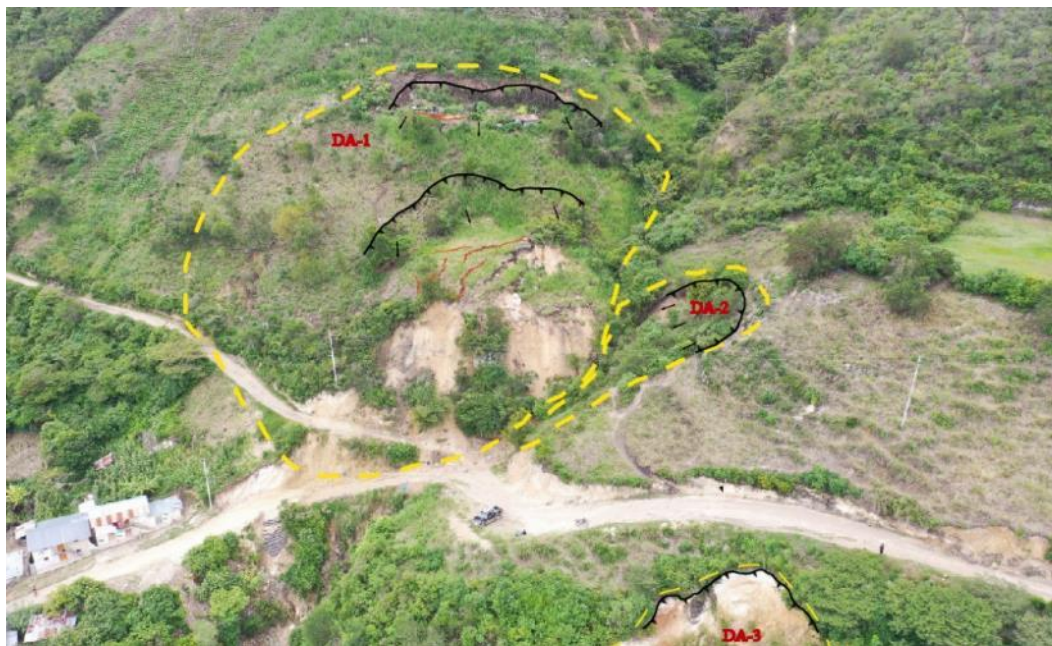
Figura 10. Se observa los deslizamientos identificados, delimitados en línea amarilla, y algunas de las viviendas y vías expuestas a los movimientos en masa.
