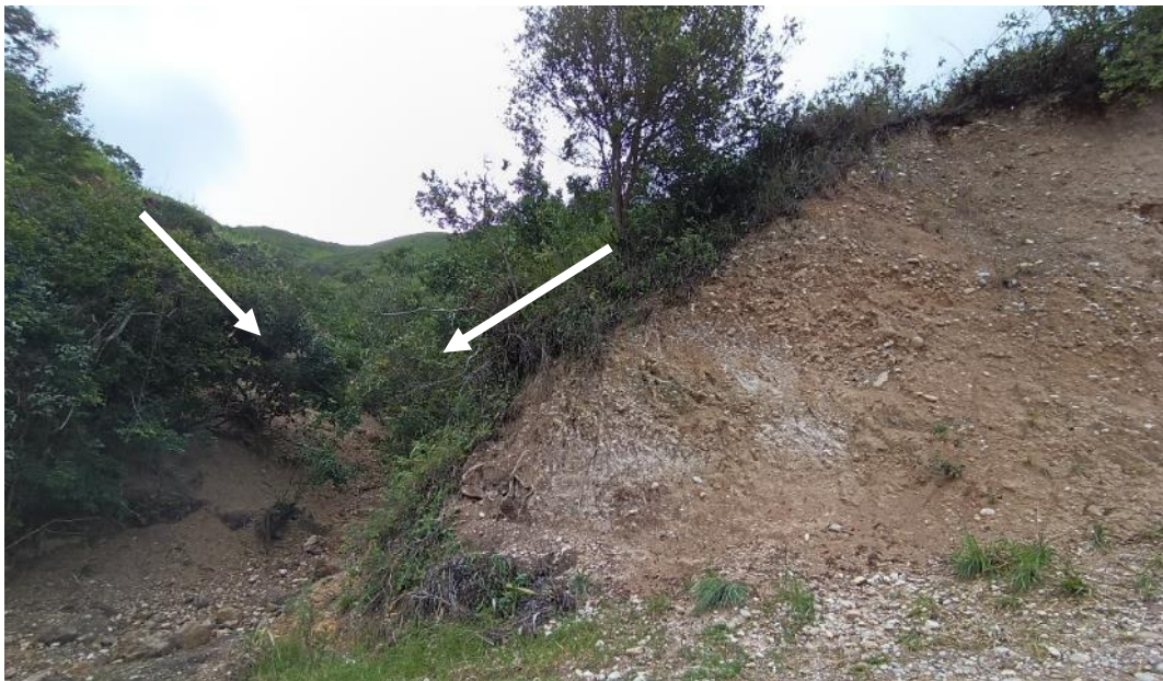
Figura 18. Se observa que el cauce de la quebrada fue obstruido de manera temporal por el material deslizado.
