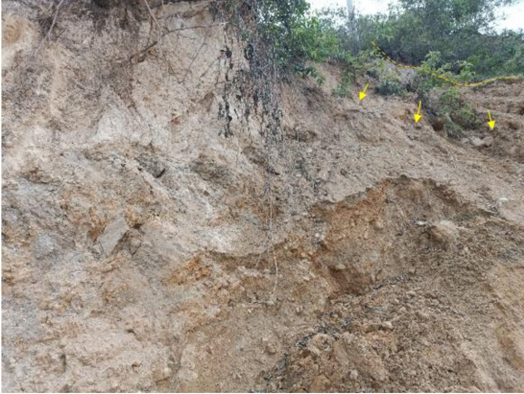
Figura 5. Depósito coluvio – deluvial, ubicado en la zona de deslizamiento en Cunuat. Coordenadas UTM WGS84 17M. 771075, 9323391.
