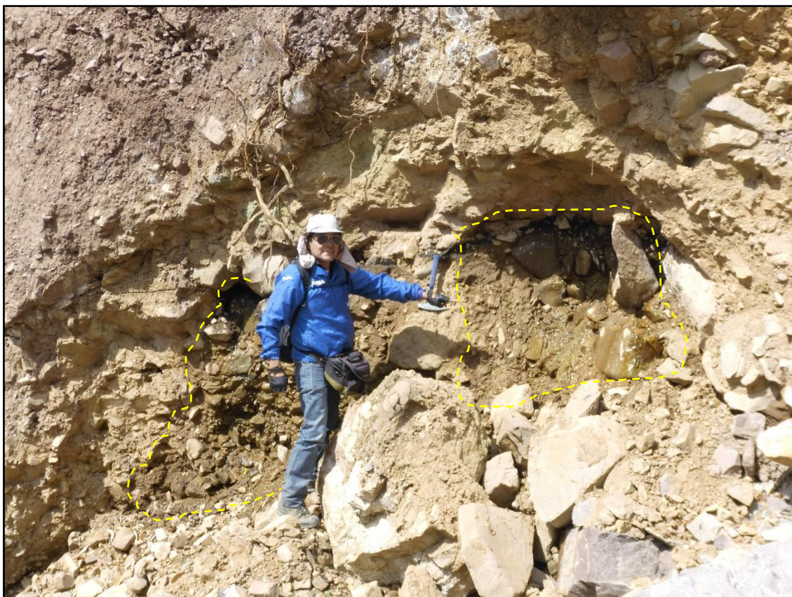
Figura 13. Surgencias de agua en las partes bajas de la ladera de la quebrada Inqui.
