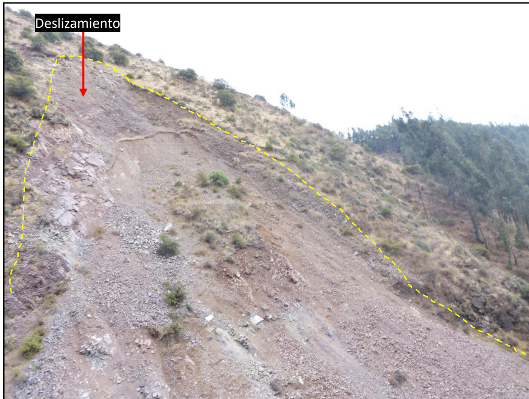
Figura 12. Deslizamiento Inqui, ubicado en la margen izquierda de la quebrada Inqui.
