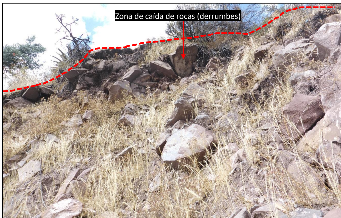
Figura 14. Derrumbe en la margen derecha de la quebrada Inqui, en el punto UTM E 805666, N 8455592.
