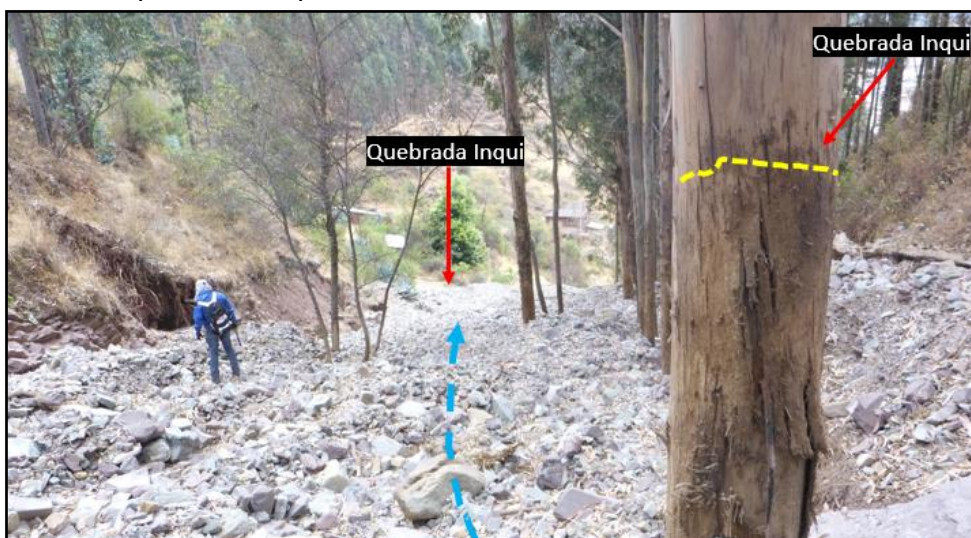
Figura 8. Cauce de la quebrada Inqui, además se aprecia la huella dejada por el flujo en los árboles.
