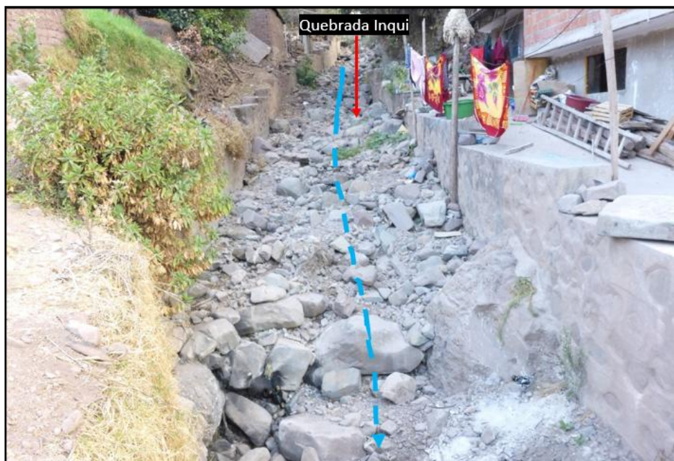
Figura 9. Cauce de la quebrada Inqui, se encuentra canalizado al entrar a la zona urbana de Tambobamba.
