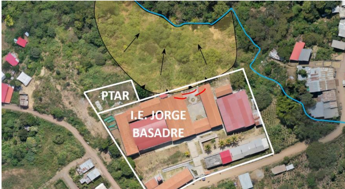
Figura 11. En la figura se muestra la delimitación actual del deslizamiento (dentro del polígono amarillo) y su dirección hacia a quebrada temporal; así como los agrietamientos principales (líneas rojas).
